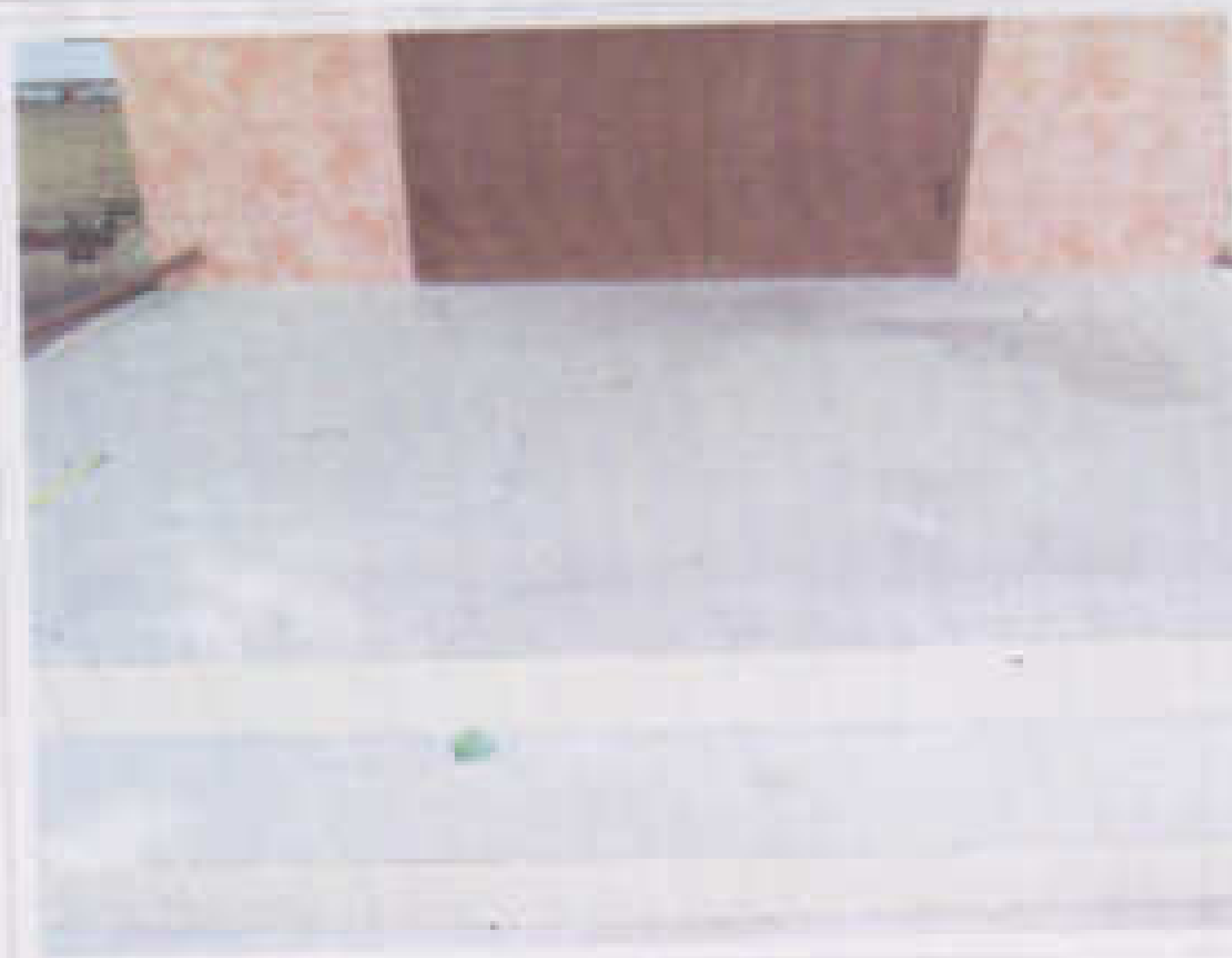
Фото 5. Входная площадка (перед входной дверью)
