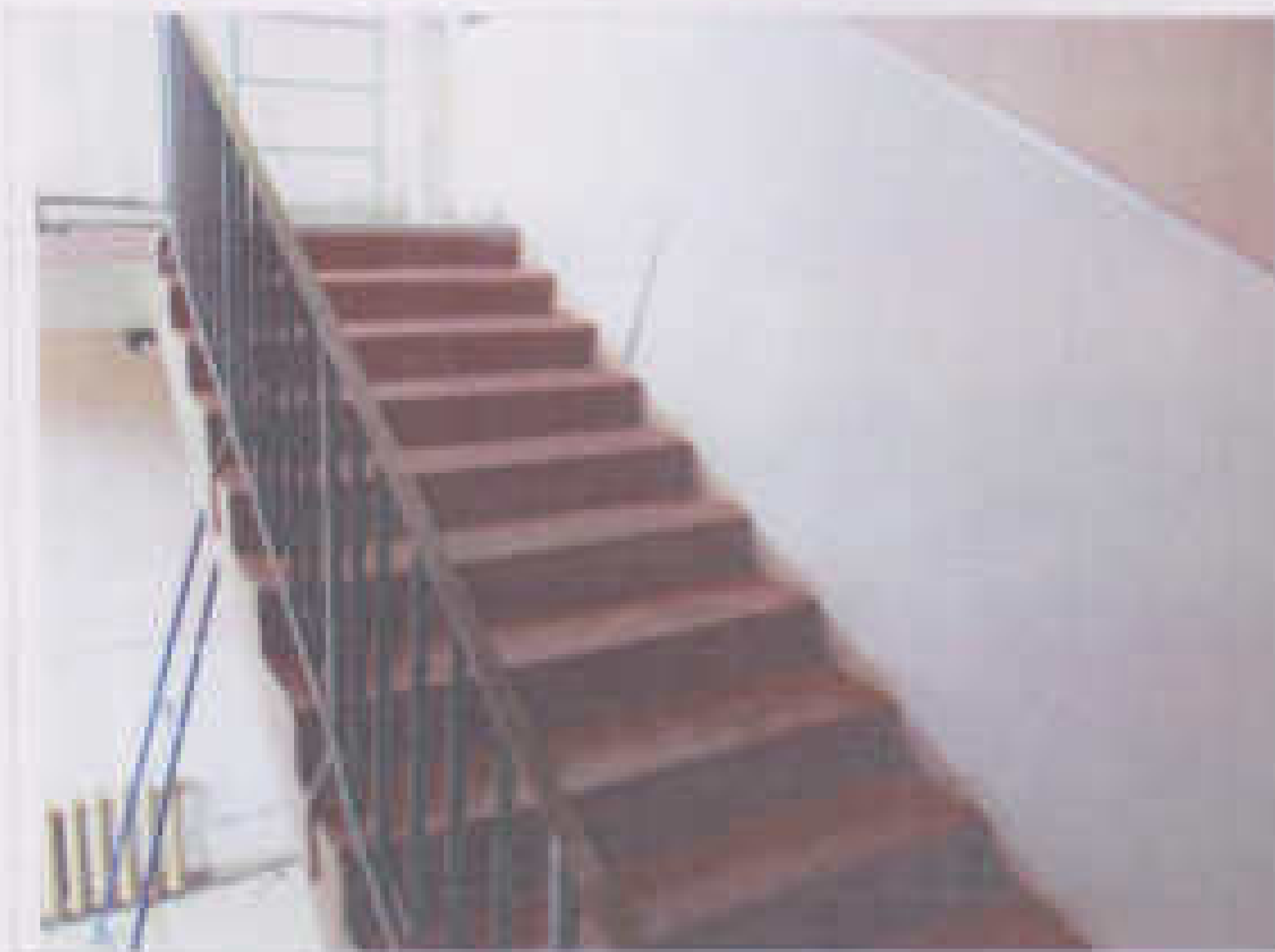
Фото 19. Внутренние лестницы (междутяговые)
