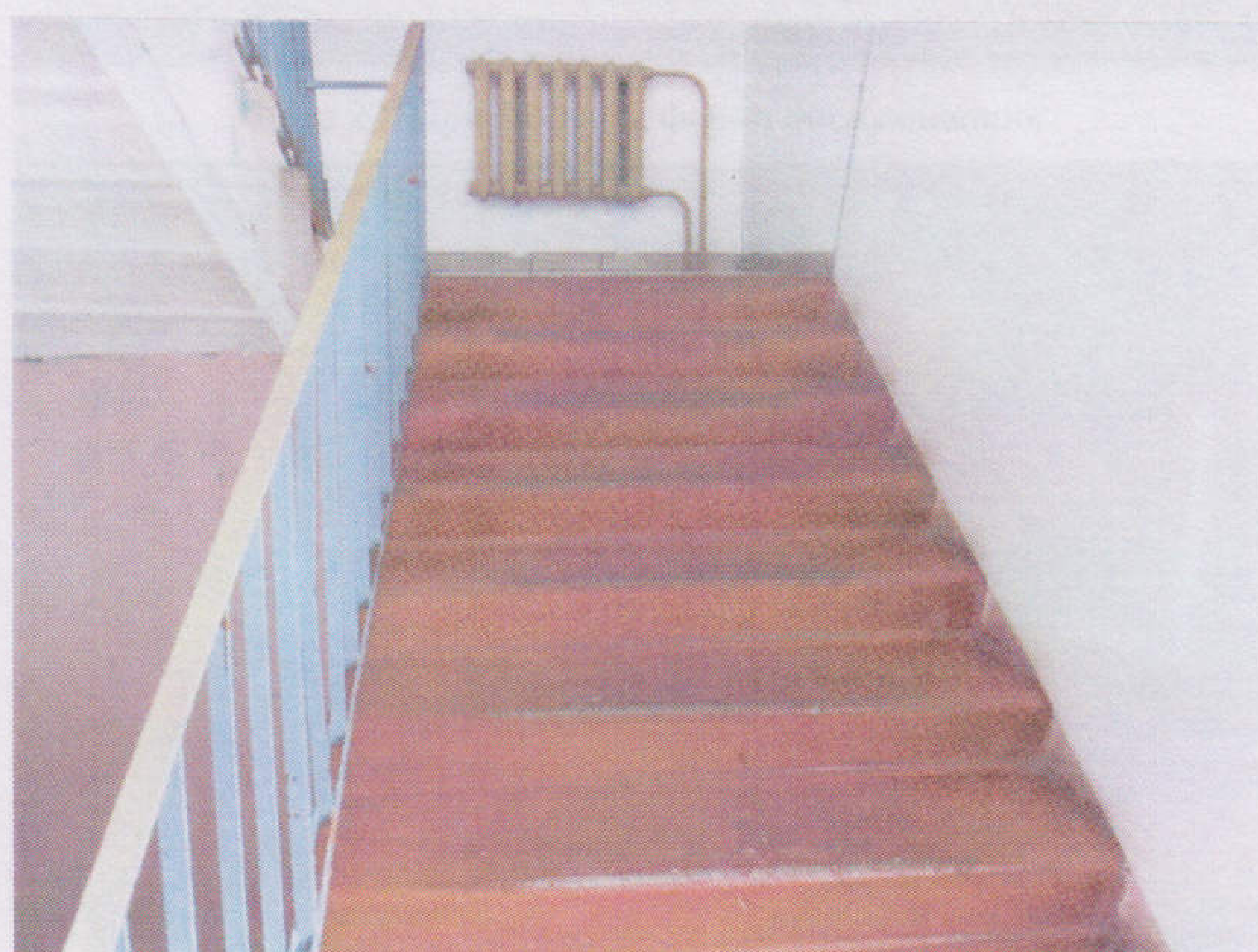
Фото 18 Внутренние лестницы (междуэтажные)
