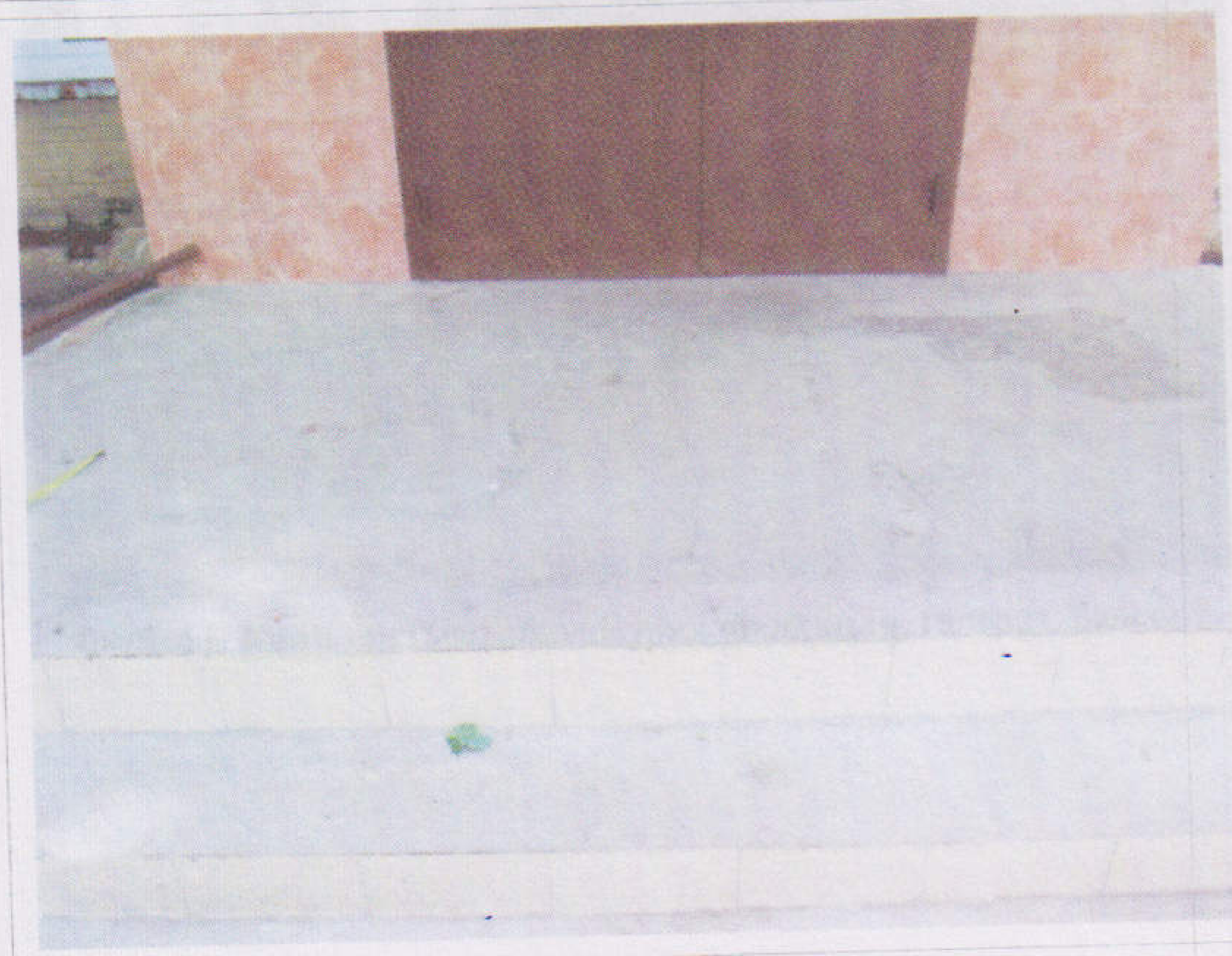
Фото 5 Входная площадка (перед входной дверью)
