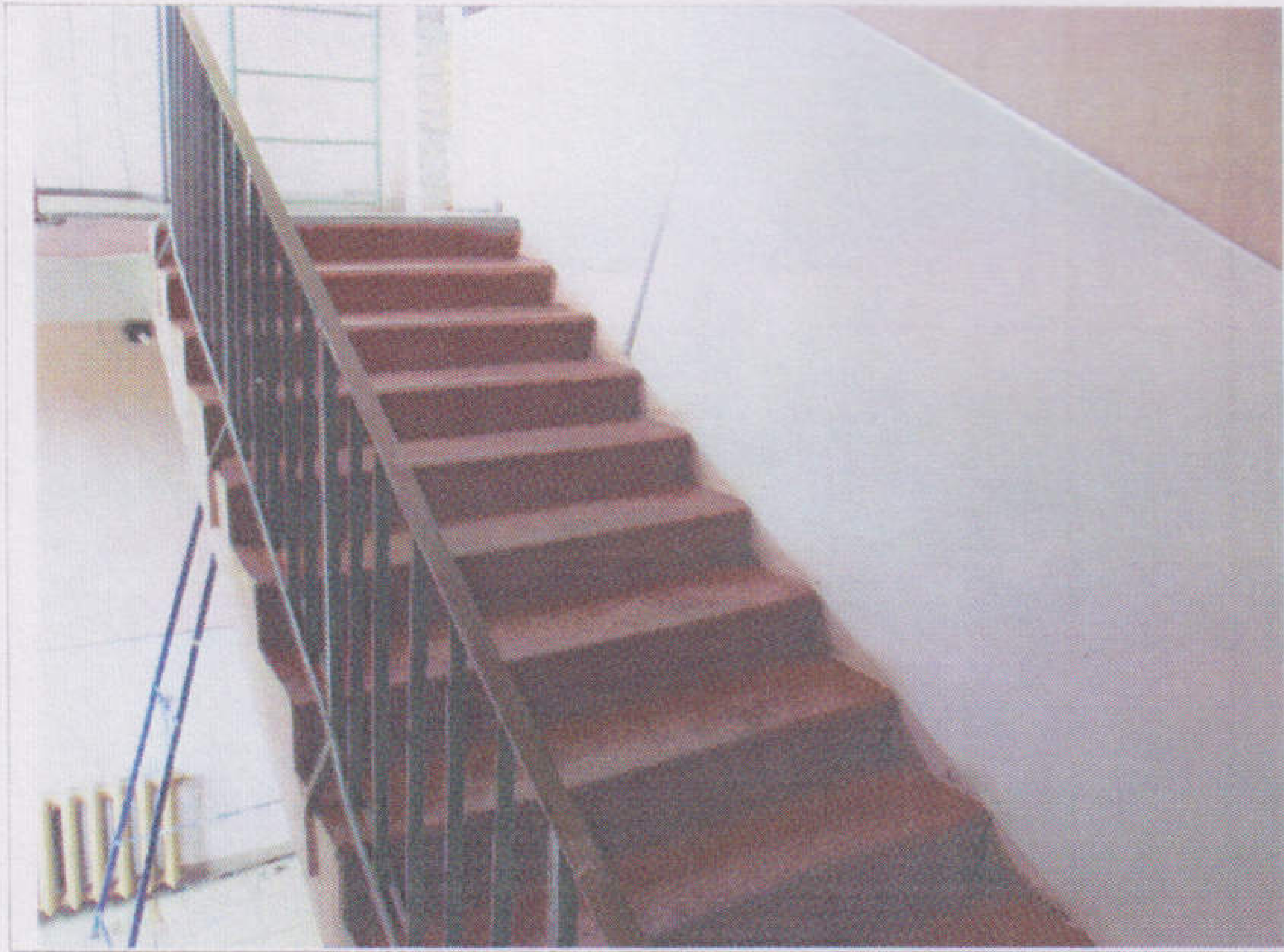
Фото 19 Внутренние лестницы (междуэтажные)
