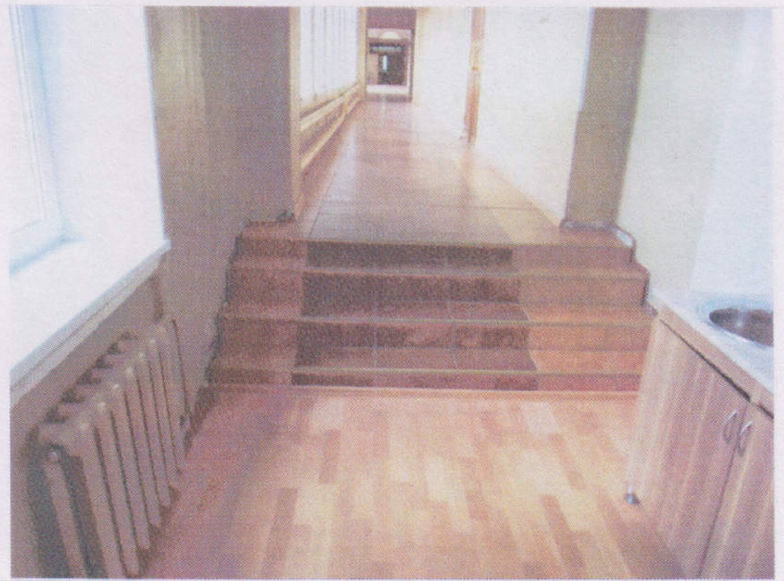
Фото 20 Внутренние лестницы (на первом этаже)
