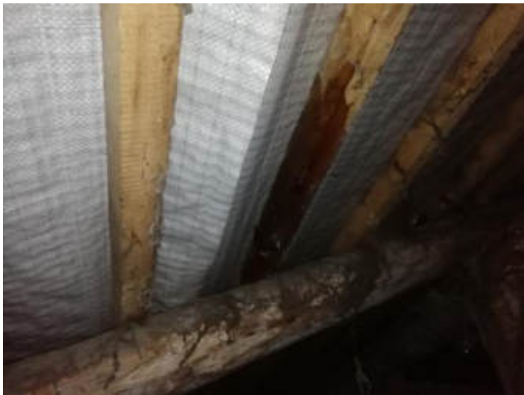
Фото 59. Чердачное помещение, корпус 1. Стропильная система, обрешётка. Старые и свежие следы намокания деревянных конструкций
