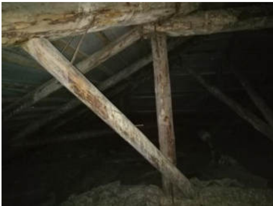
Фото 41. Чердачное помещение, корпус 1. Стропильная система
