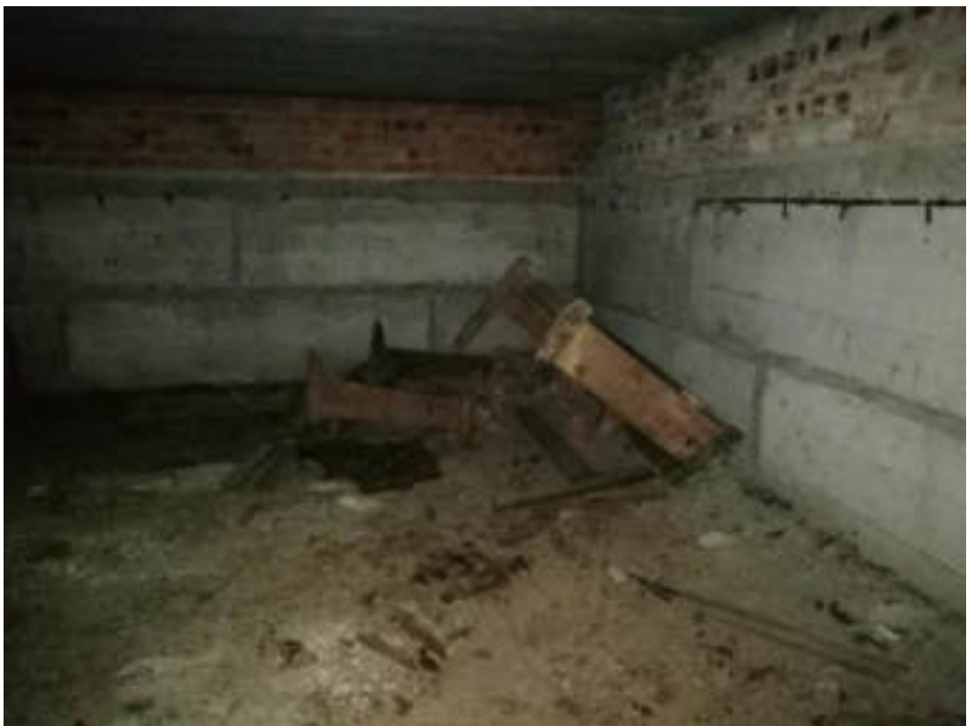
Фото 72. Подвал корпуса 2. Фундамент здания. Полы. Строительный мусор
