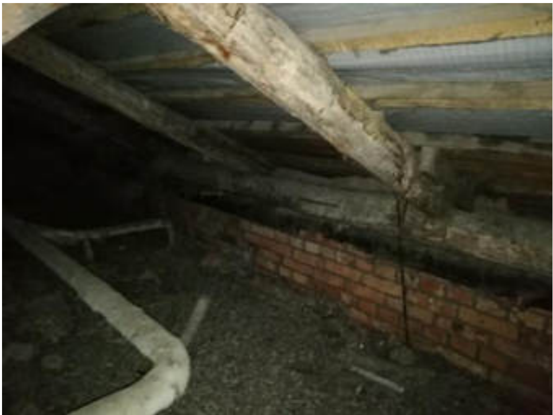
Фото 50. Чердачное помещение, корпус 1. Стропильная система, обрешётка. Старые и свежие следы намокания деревянных конструкций
