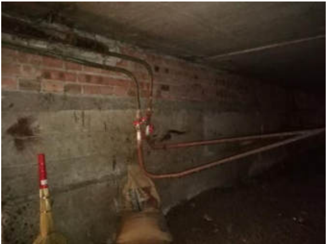
Фото 67. Подвал корпуса 2. Фундамент здания. Плиты перекрытия над подвалом
