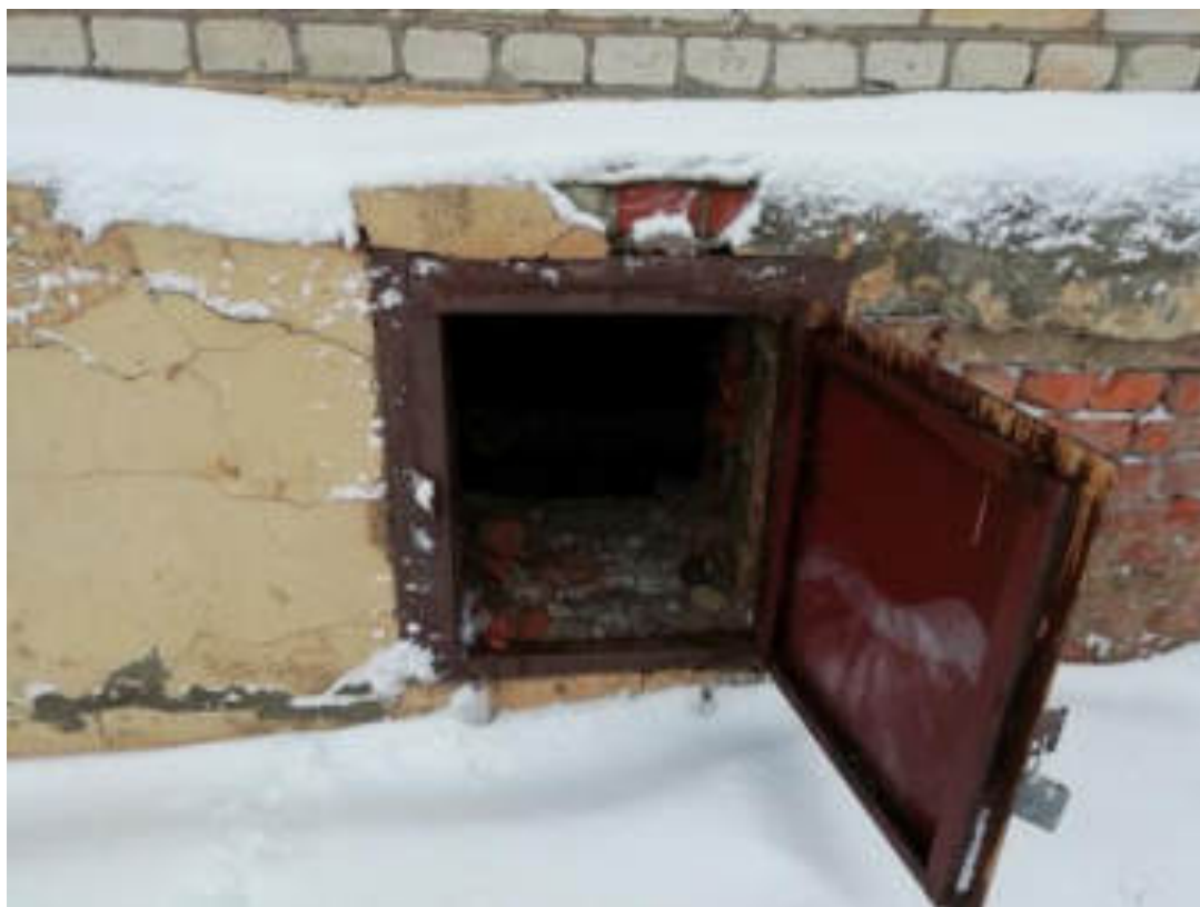
Фото 74. Люк и лаз в подвал корпуса 1 через фундамент здания
