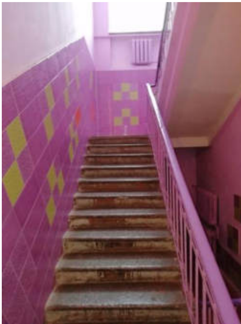
Фото 81. Лестница 1 корпус 1. Наборные ступени по металлическим косоурам
