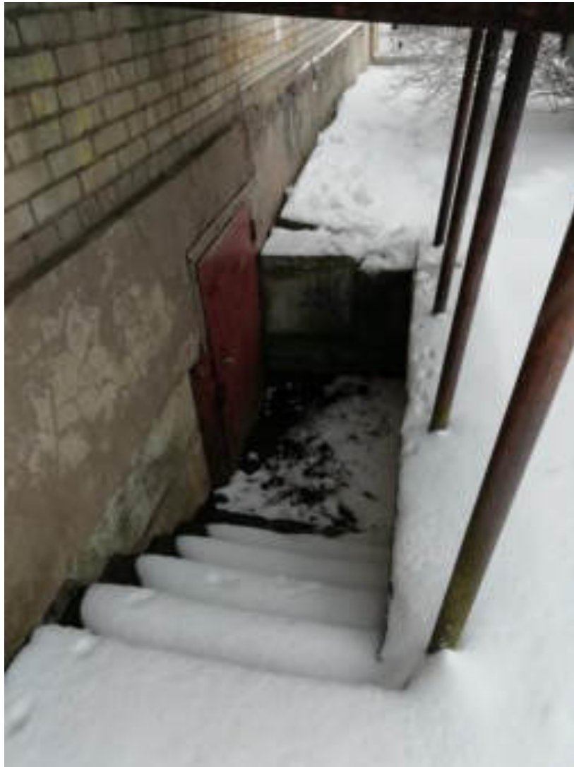
Фото 23. Лестница входа в подвал корпуса 2. Стойки козырька над входом
