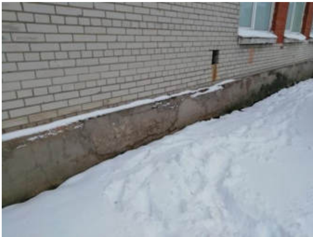
Фото 21. Цоколь корпуса 2 здания школы западной стороны. Намокание и трещины по штукатурке цоколя
