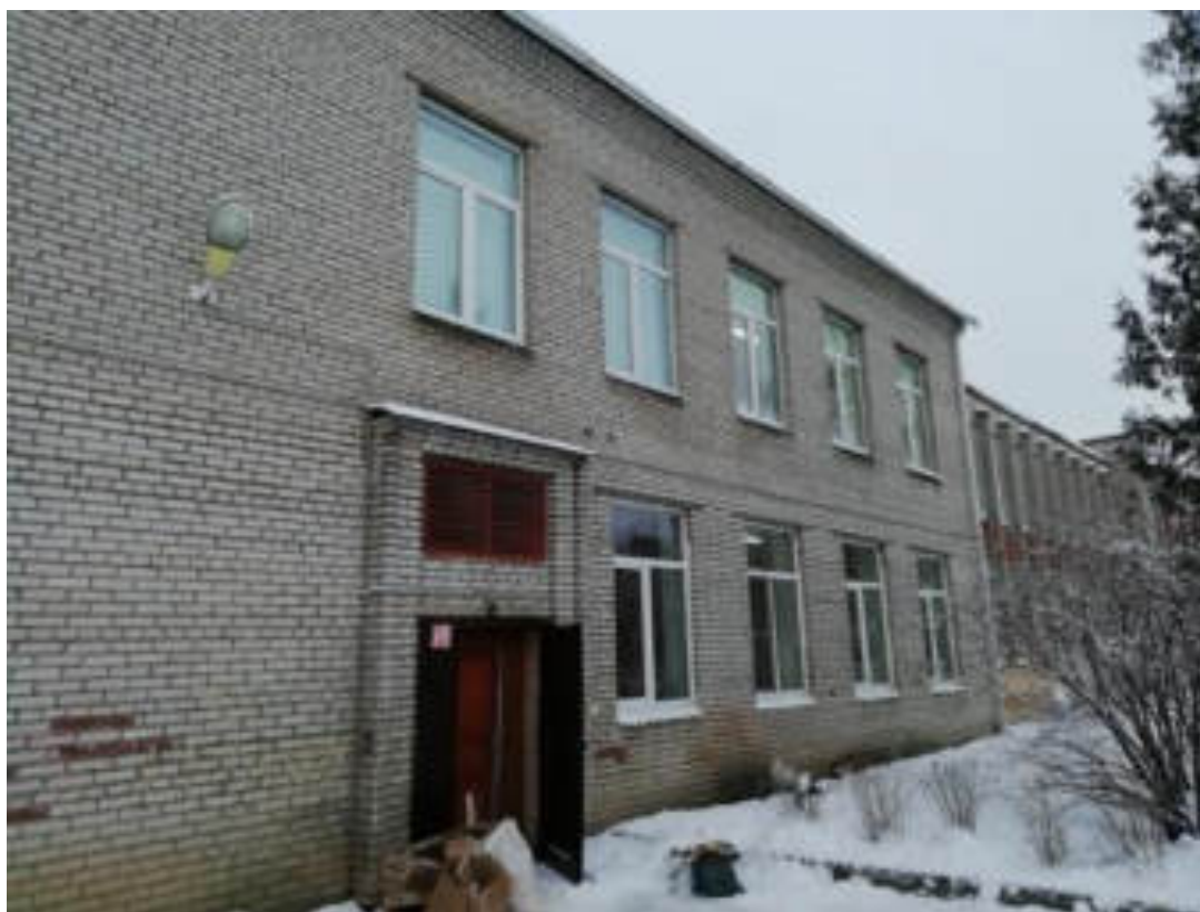
Фото 14. Здание школы, корпус 1, восточная сторона. Отдельный вход в помещение кухни
