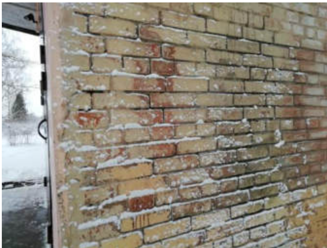
Фото 4. Кирпичная кладка правой стены тамбура главного входа. Выветренные швы, следы намочания кирпичной кладки
