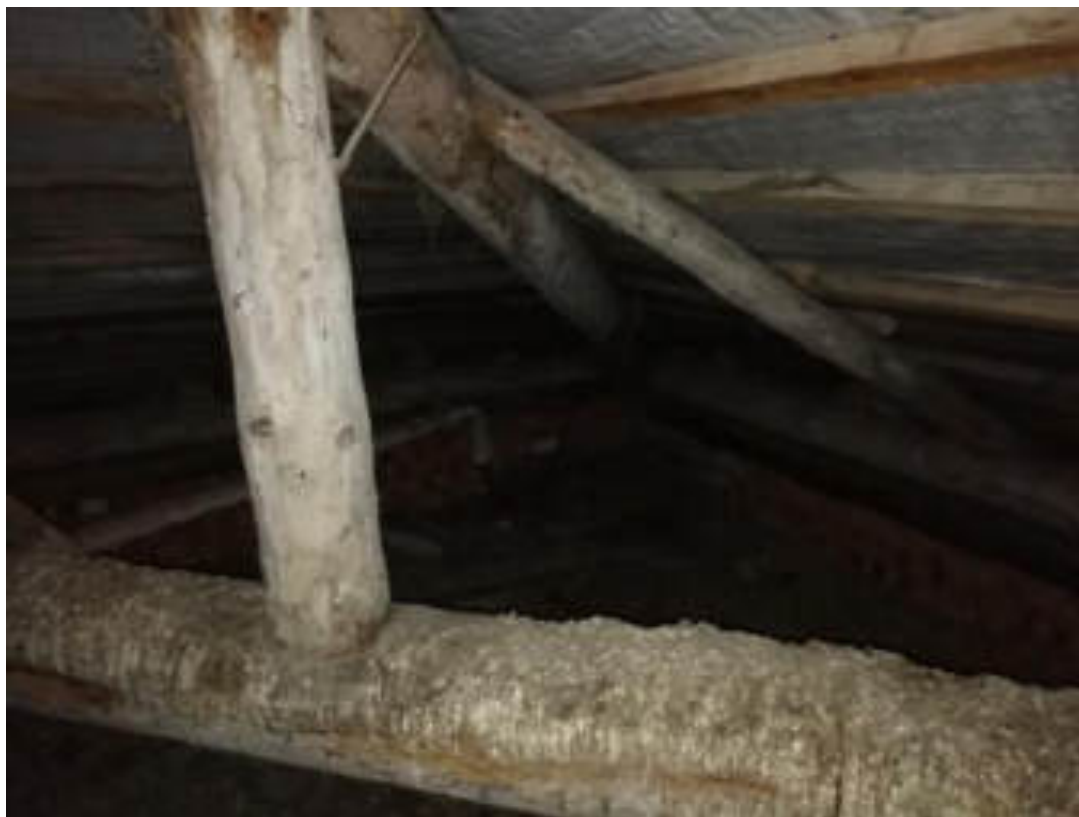
Фото 61. Чердачное помещение, корпус 1. Стропильная система, обрешётка
