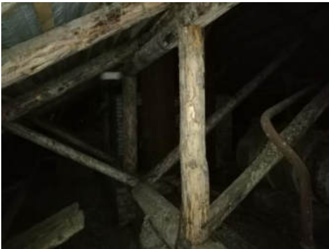
Фото 51. Чердачное помещение, корпус 1. Стропильная система, подпорные стойки и укосы под стропилами
