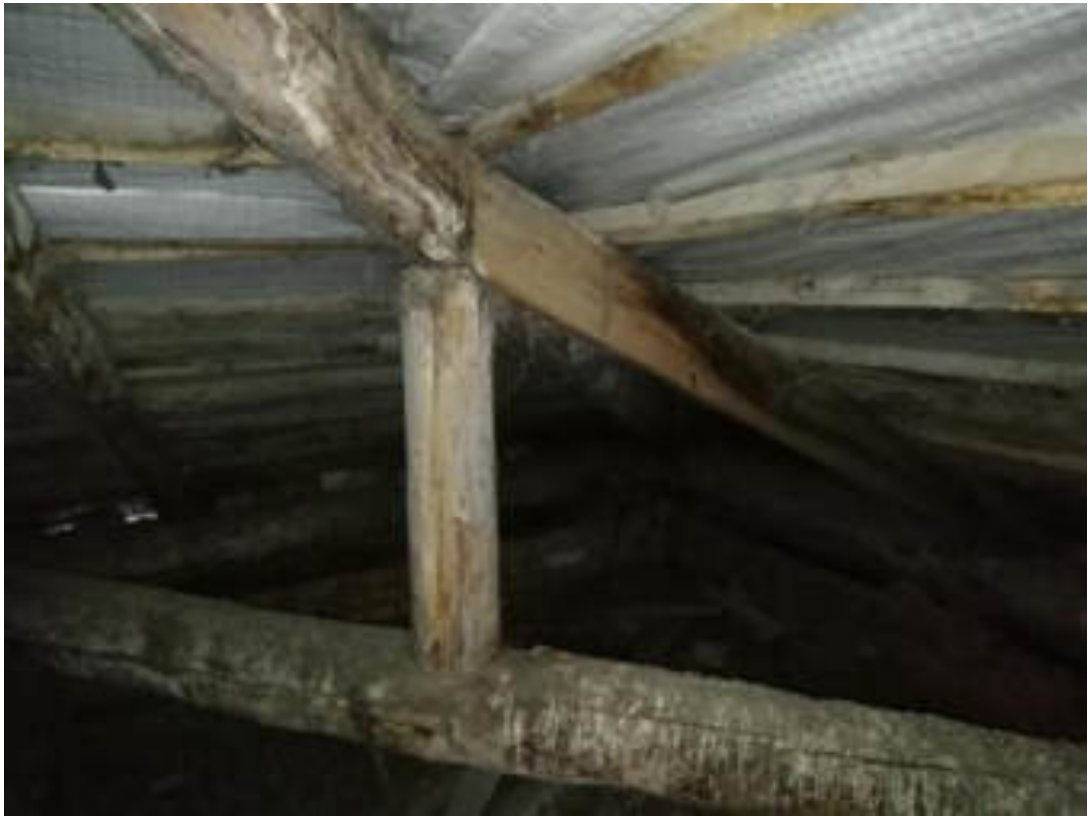
Фото 46. Чердачное помещение, корпус 1. Стропильная система, обрешётка. Следы намокания деревянных конструкций
