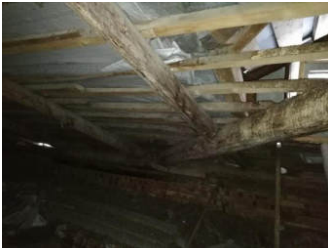
Фото 40. Чердачное помещение, корпус 1. Стропильная система, обрешётка, слуховое окно. Старые следы намокания по деревянным конструкциям
