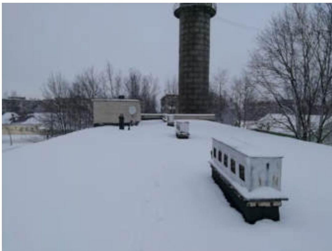
Фото 36. Плоская кровля корпуса 2
