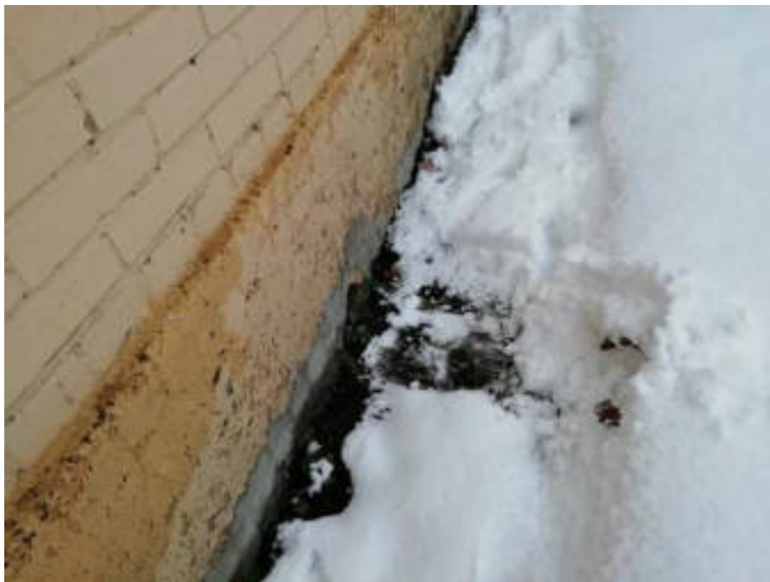
Фото 11. Цоколь здания школы восточной стороны. Намокание и трещины по штукатурке цоколя
