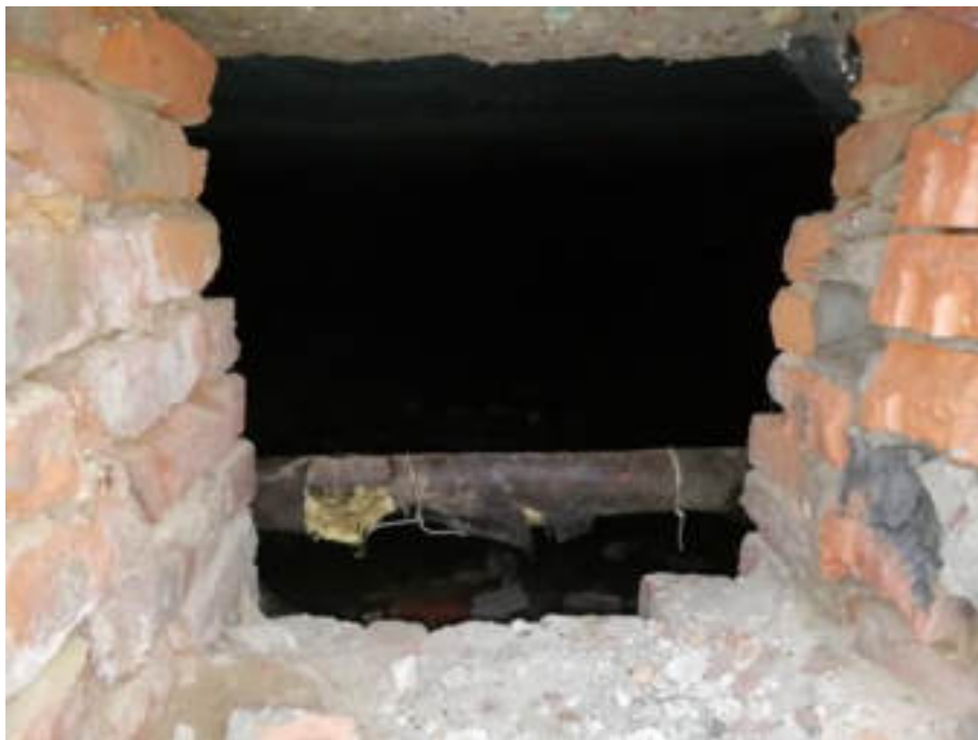
Фото 75. Лаз в подвал корпуса 1 через фундамент здания
