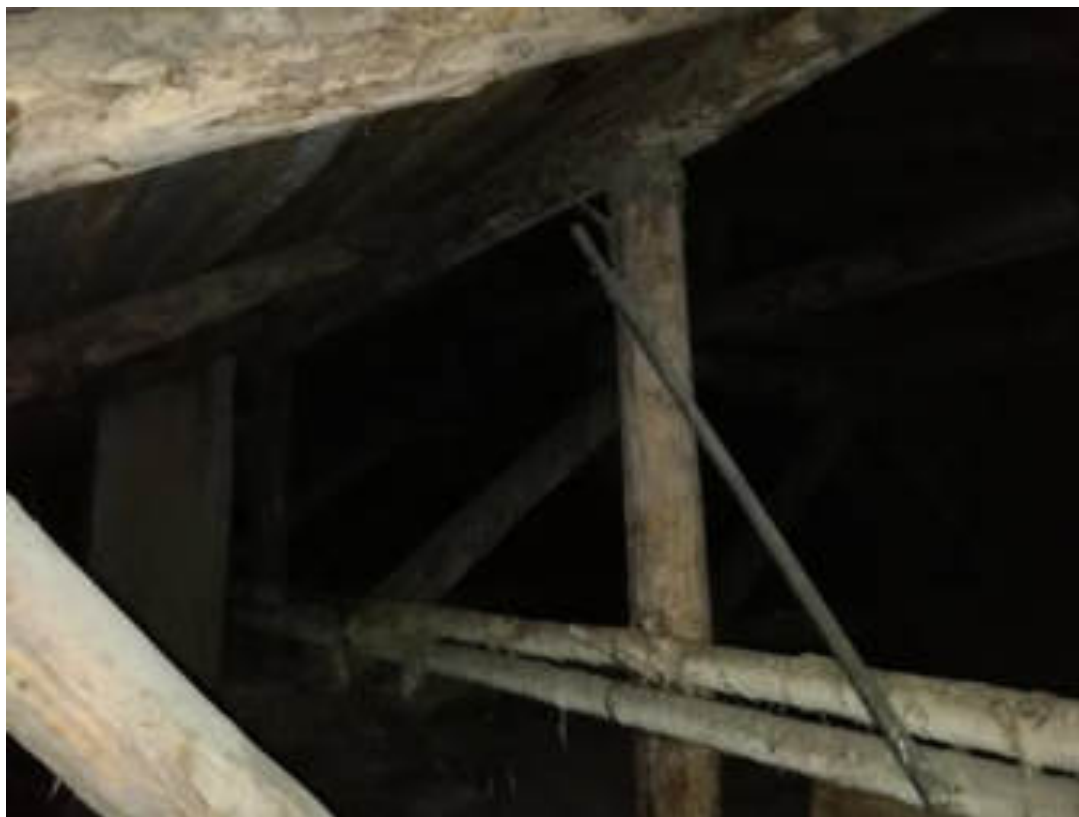
Фото 57. Чердачное помещение, корпус 1. Стропильная система
