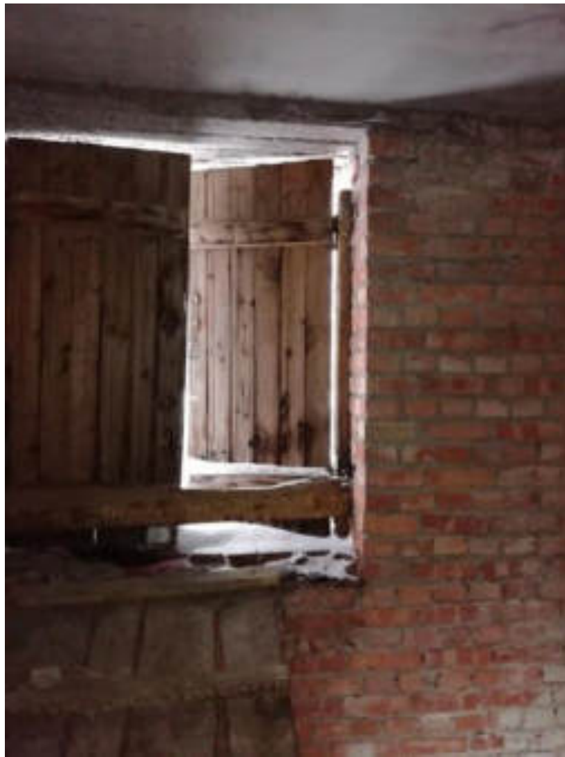
Фото 33. Выход на плоскую кровлю из чердачного помещения над лестницей 3 корпуса 2
