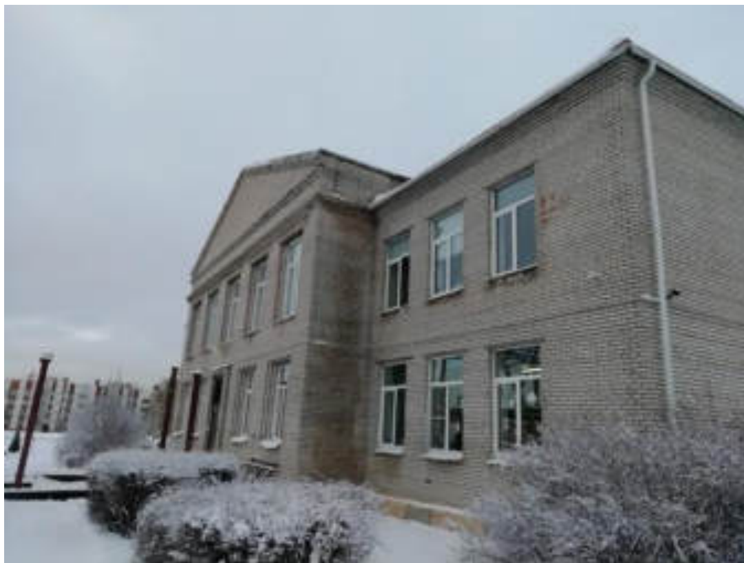
Фото 15. Здание школы, корпус 1, южная сторона. Снег на кирпичной кладке карниза. Минимальный карнизный свес кровли
