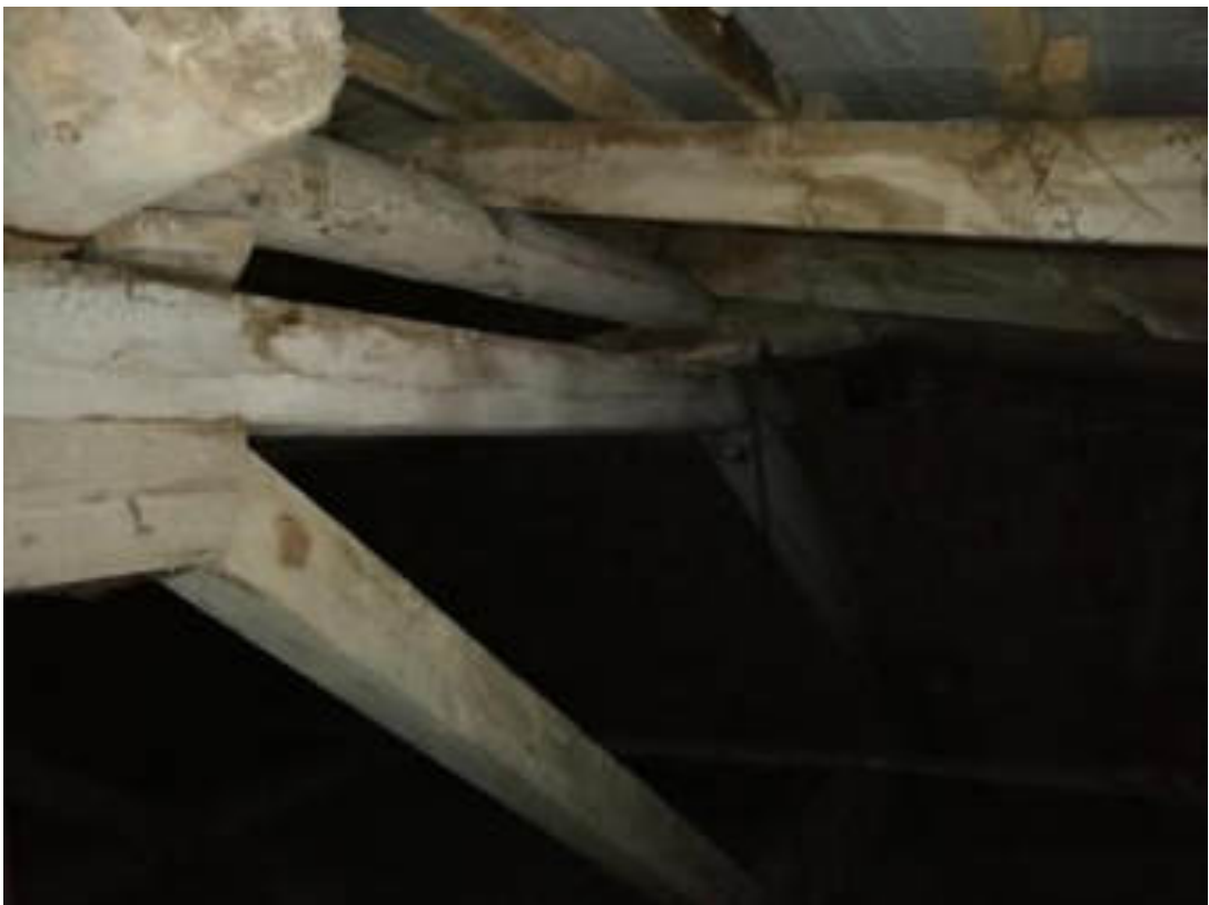
Фото 64. Чердачное помещение, корпус 1. Стропильная система. Старые следы намокания деревянных конструкций
