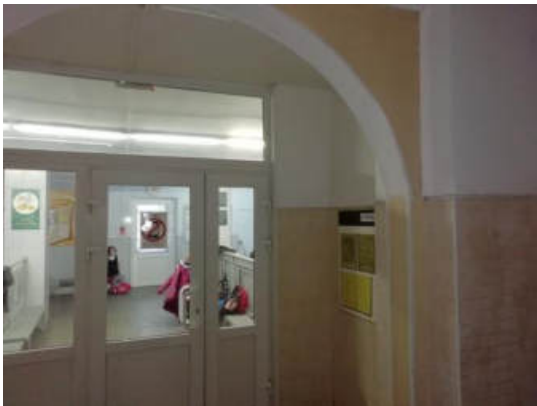
Фото 98. Тамбур главного входа. Входная зона. Дверной блок из ПВХ профиля
