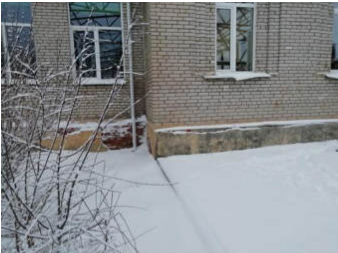
Фото 31. Цоколь здания школы южной стороны. Трещины и отслоение штукатурки цоколя
