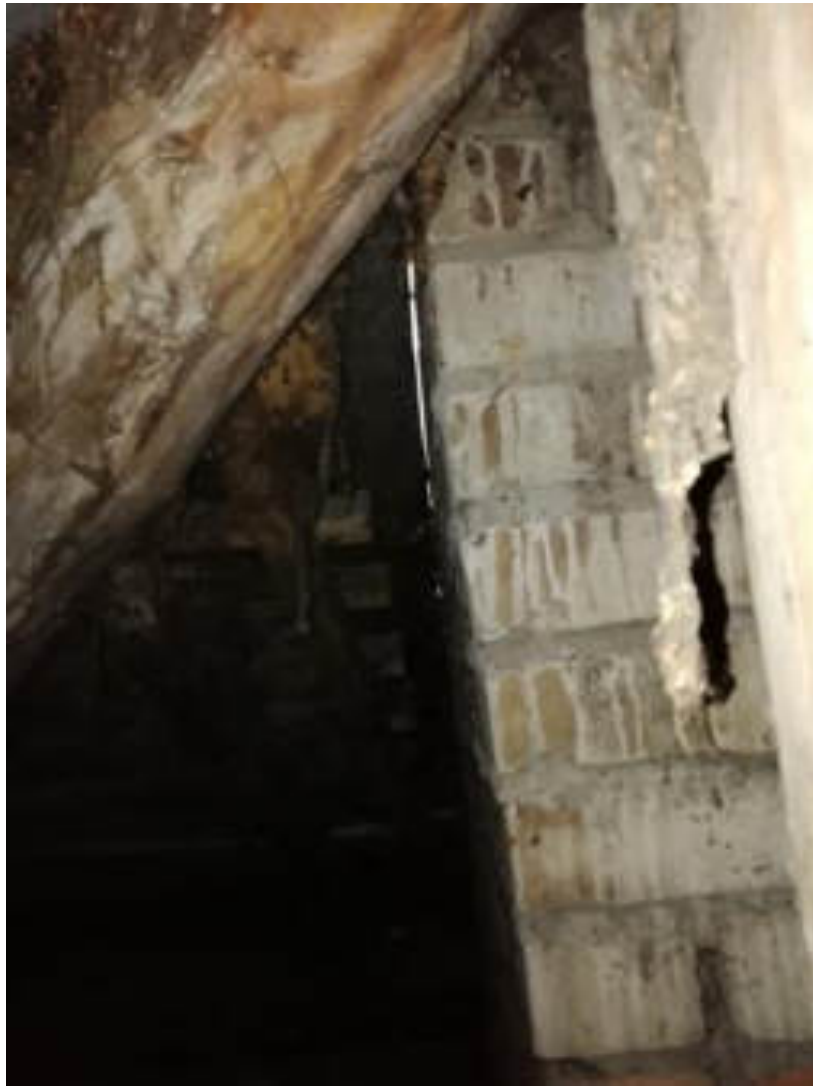
Фото 48. Чердачное помещение, корпус 1. Стропильная система. Просветы в примыкании кровли к кирпичной кладке вентшафт
