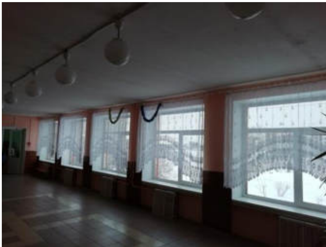
Фото 101. Коридор (рекреация) 1-го этажа школы, корпус 2.
