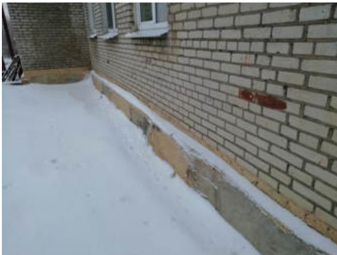
Фото 16. Цоколь здания школы южной стороны. Трещины по штукатурке цоколя
