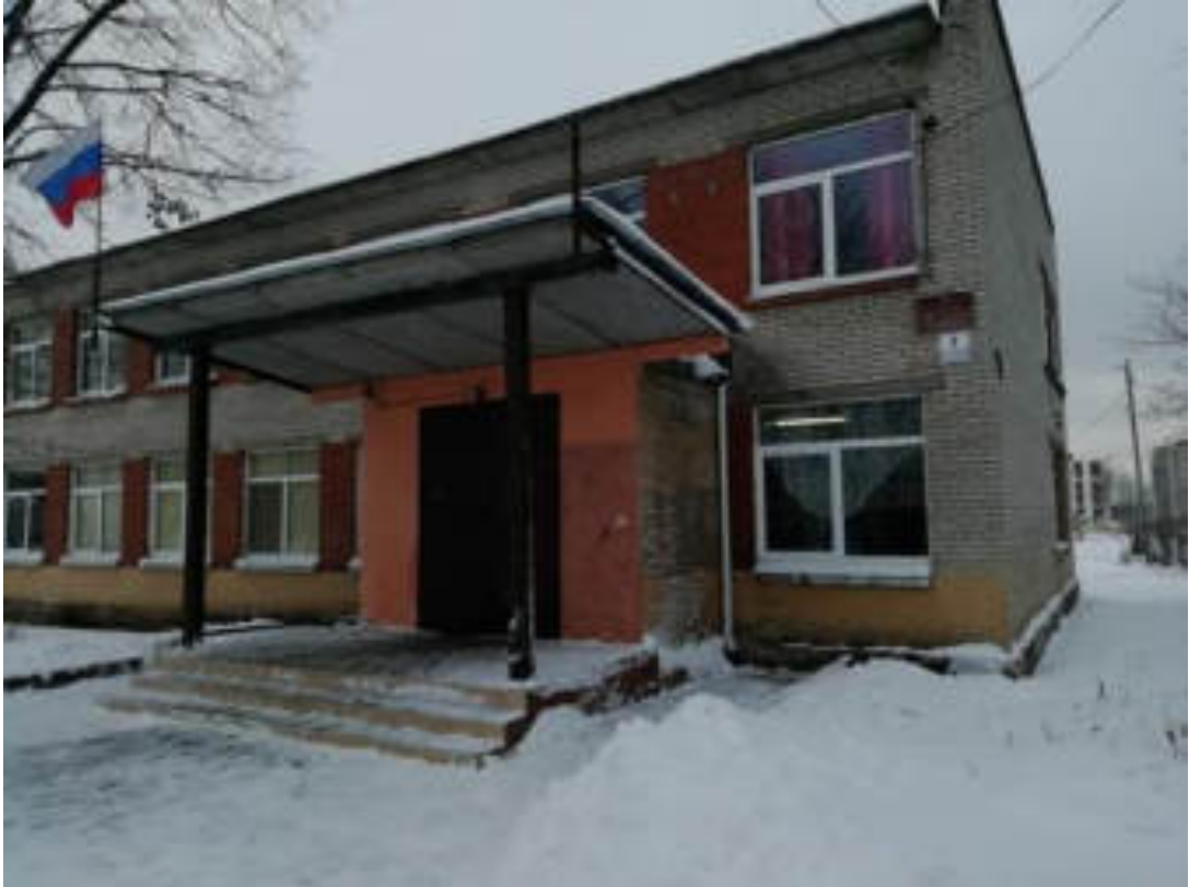
Фото 1. Здание школы, корпус 2, восточная сторона. Крыльцо главного входа
