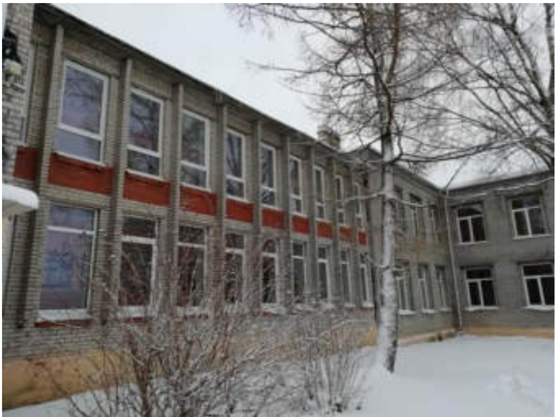
Фото 25. Здание школы, переход от корпуса 2 к корпусу 1, западная сторона
