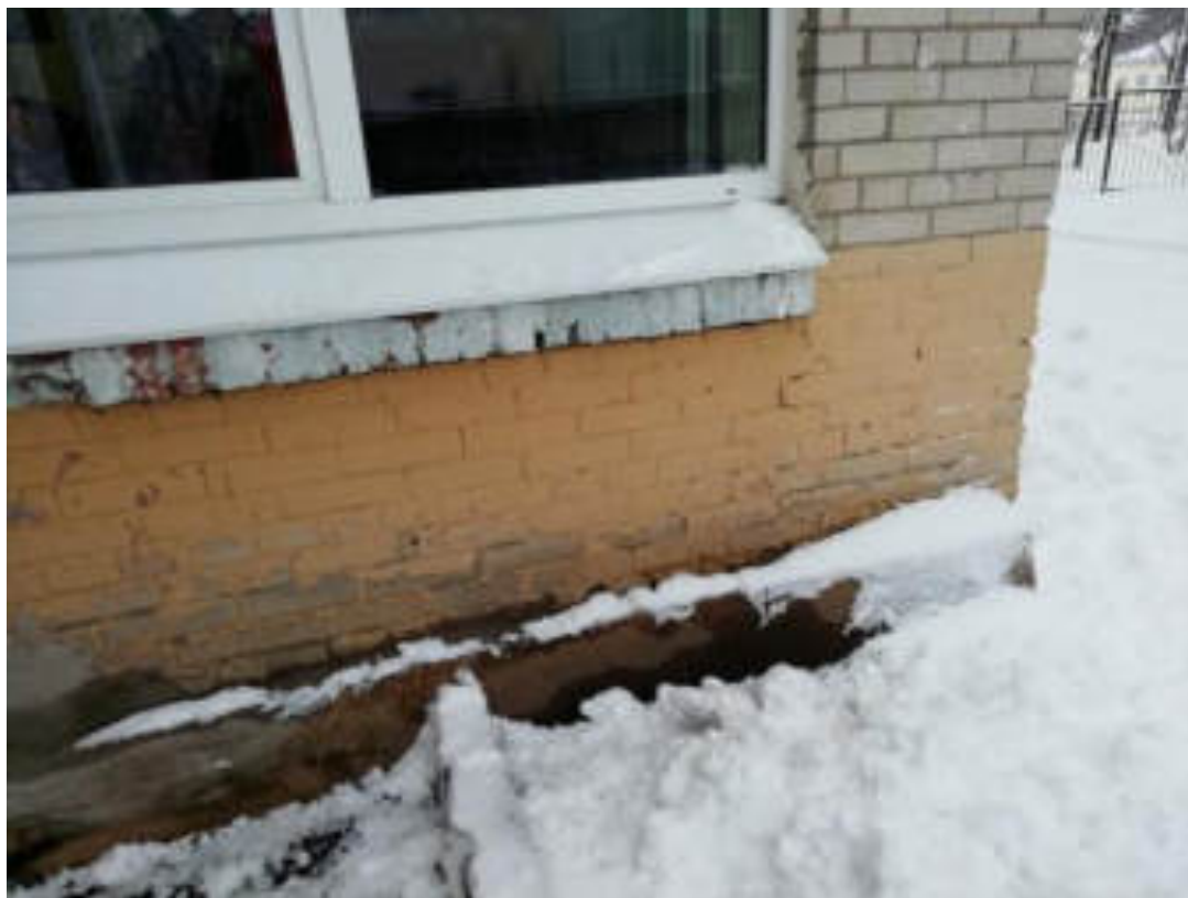
Фото 5. Участок стены справа от крыльца главного входа. Намокание и трещины по штукатурке цоколя
