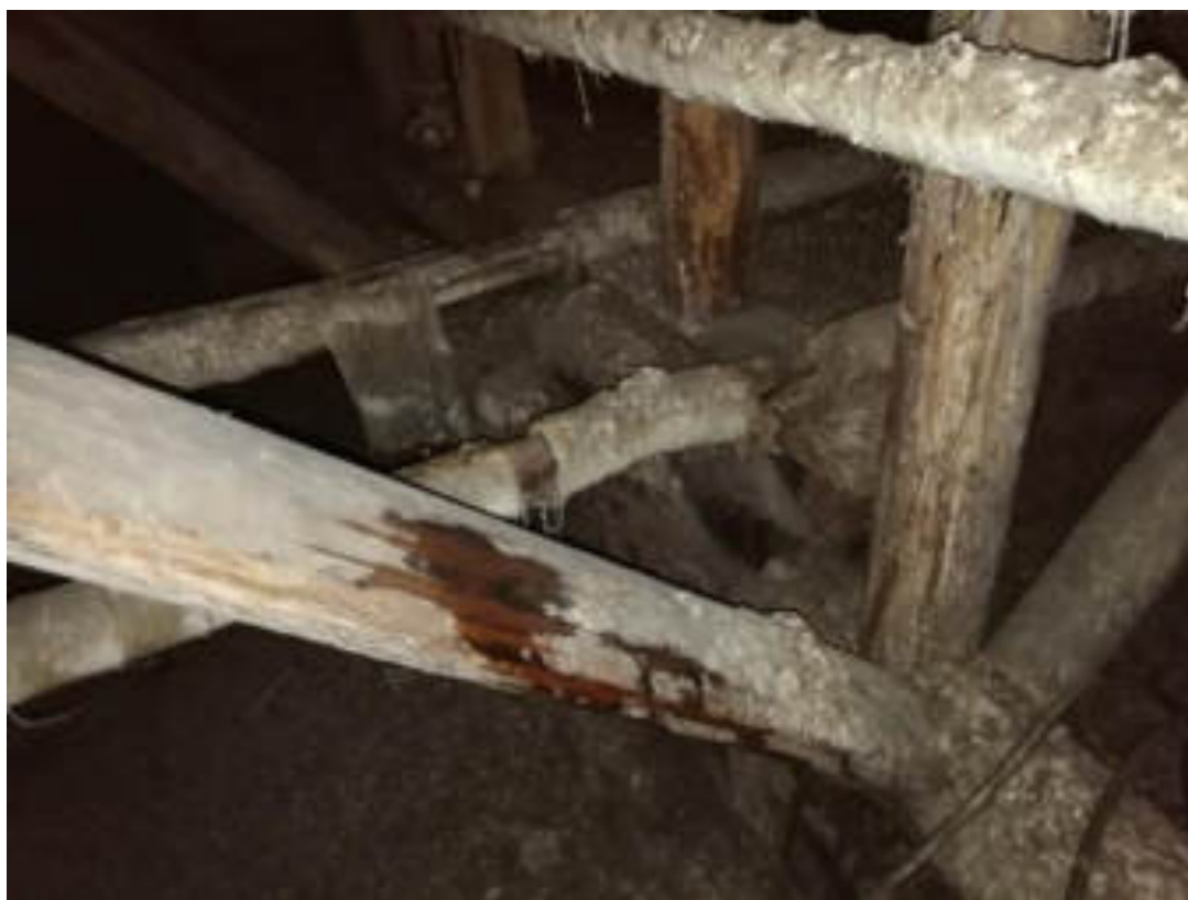
Фото 60. Чердачное помещение, корпус 1. Стропильная система, обрешётка. Свежие следы намокания деревянных конструкций
