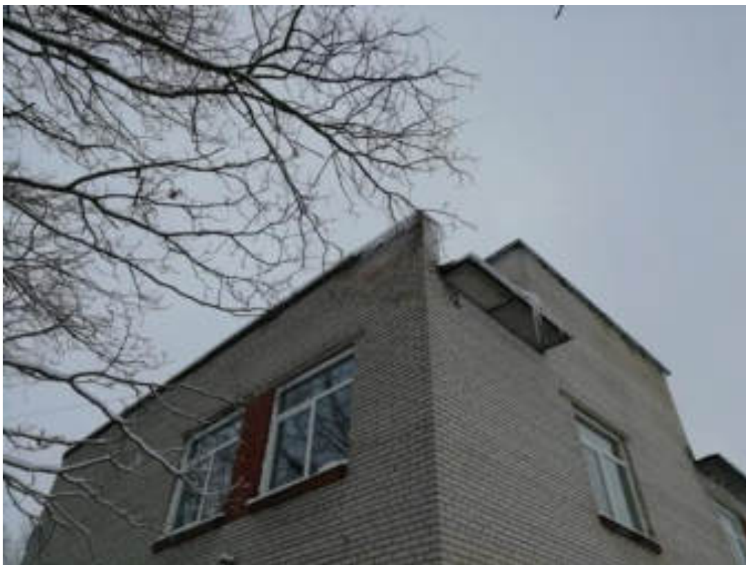
Фото 19. Участок стены, северная сторона. Отсутствие окрытия парапета, следы намокания кирпичной кладки
