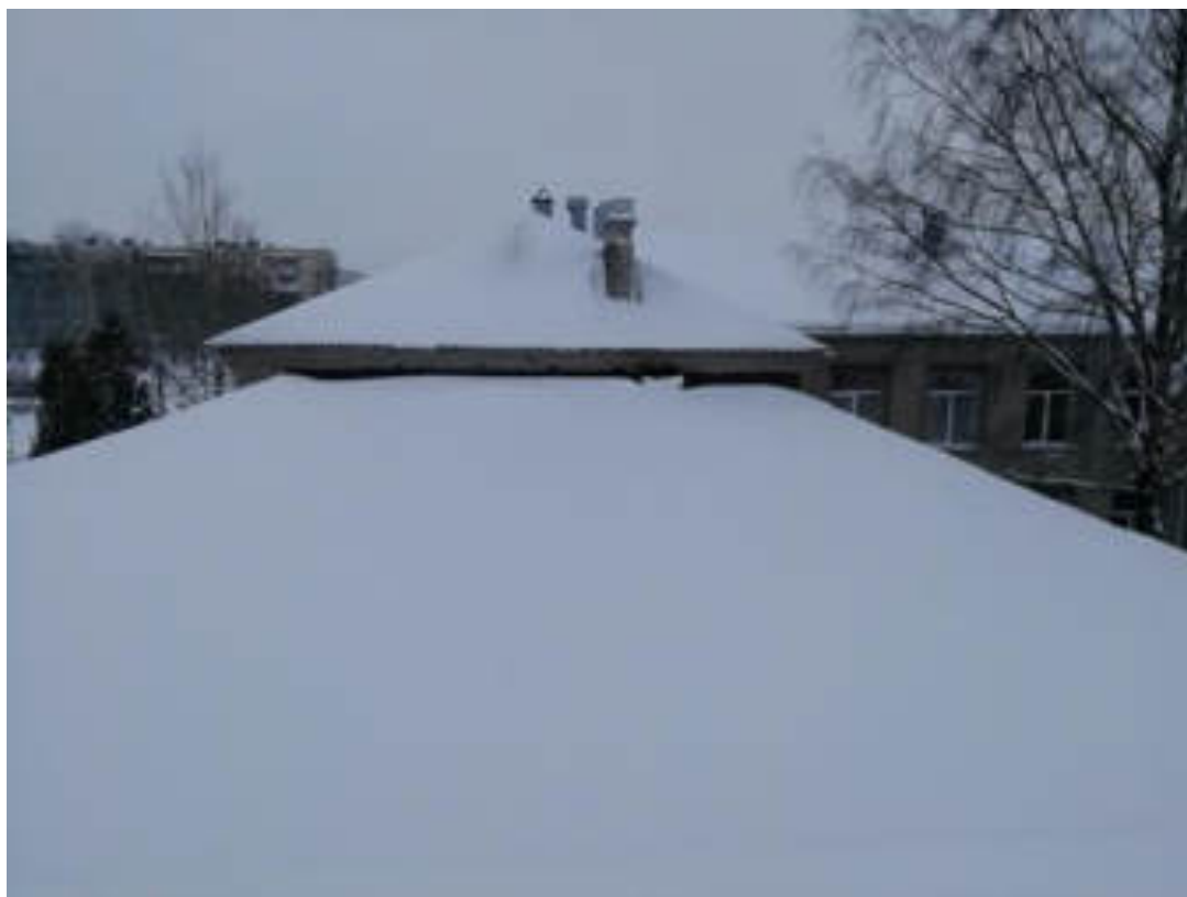
Фото 37. Участок плоской кровли перехода от корпуса 2 к корпусу 1. Вид на двухскатную кровлю корпуса 1
