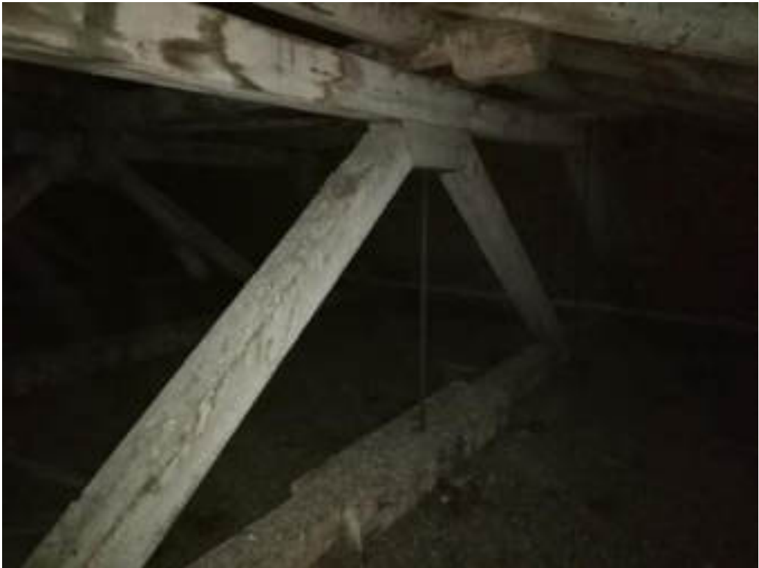
Фото 63. Чердачное помещение, корпус 1. Стропильная система. Старые следы намокания деревянных конструкций
