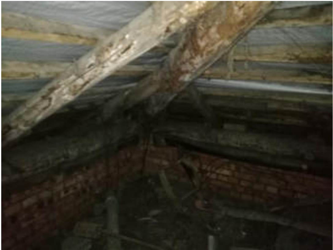
Фото 49. Чердачное помещение, корпус 1. Стропильная система, обрешётка. Старые следы намокания деревянных конструкций
