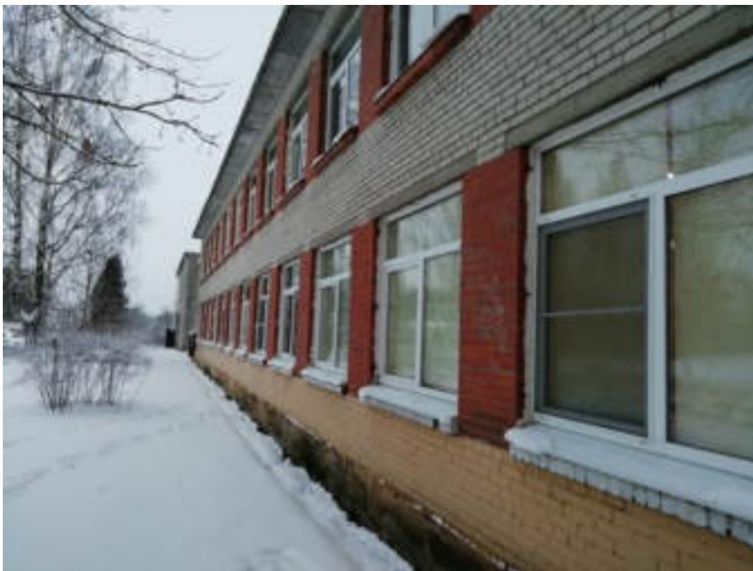
Фото 9. Здание школы, корпус 2, восточная сторона. Намокание и трещины по штукатурке цоколя
