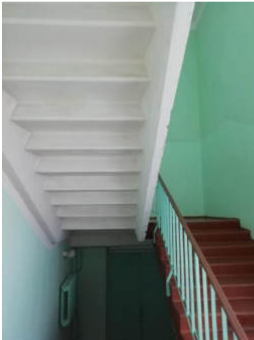
Фото 90. Лестница 2 корпус 2. Железобетонные лестничные марши и площадки
