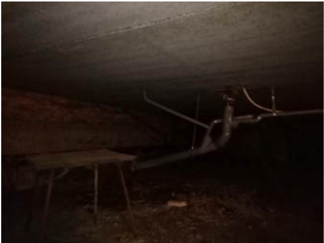
Фото 71. Подвал корпуса 2. Фундамент здания. Плиты перекрытия над подвалом. Полы
