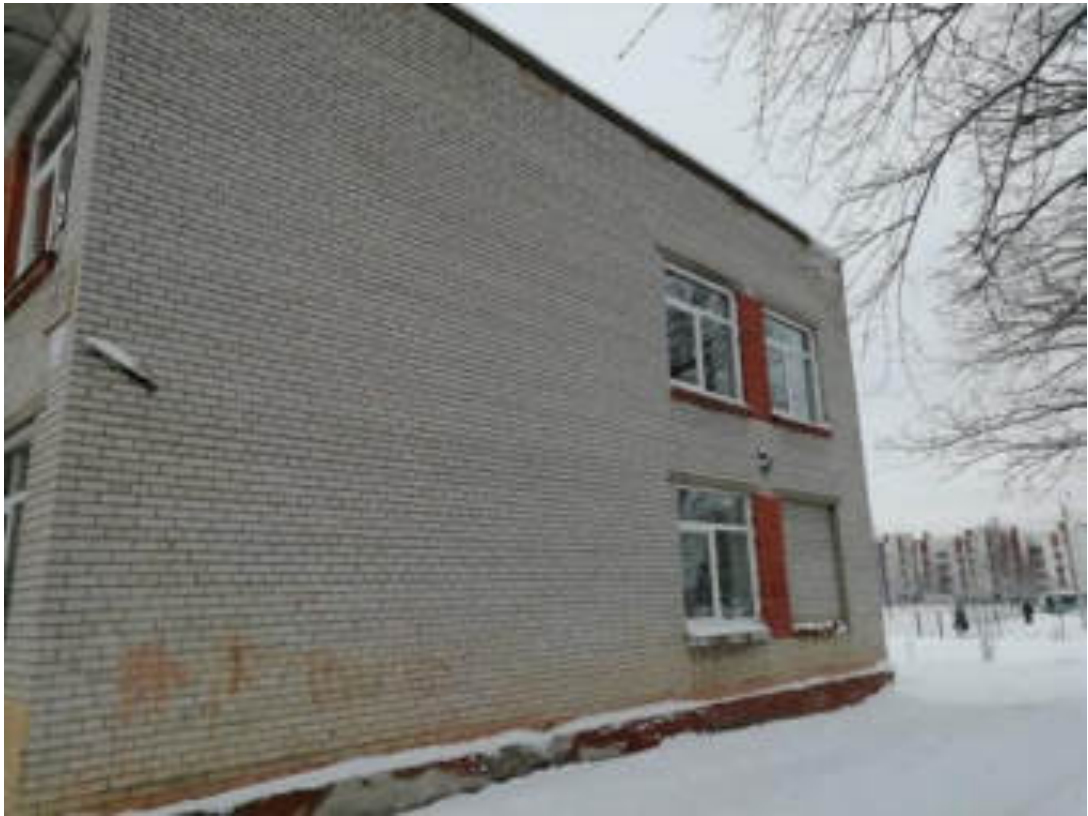
Фото 17. Здание школы, корпус 2, северная сторона. Отсутствие покрытия парапета, следы намокания кирпичной кладки. Намокание и трещины по штукатурке цоколя
