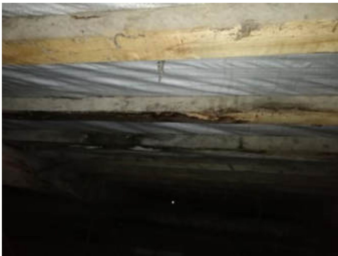
Фото 54. Чердачное помещение, корпус 1. Стропильная система, обрешётка. Старые следы намокания деревянных конструкций
