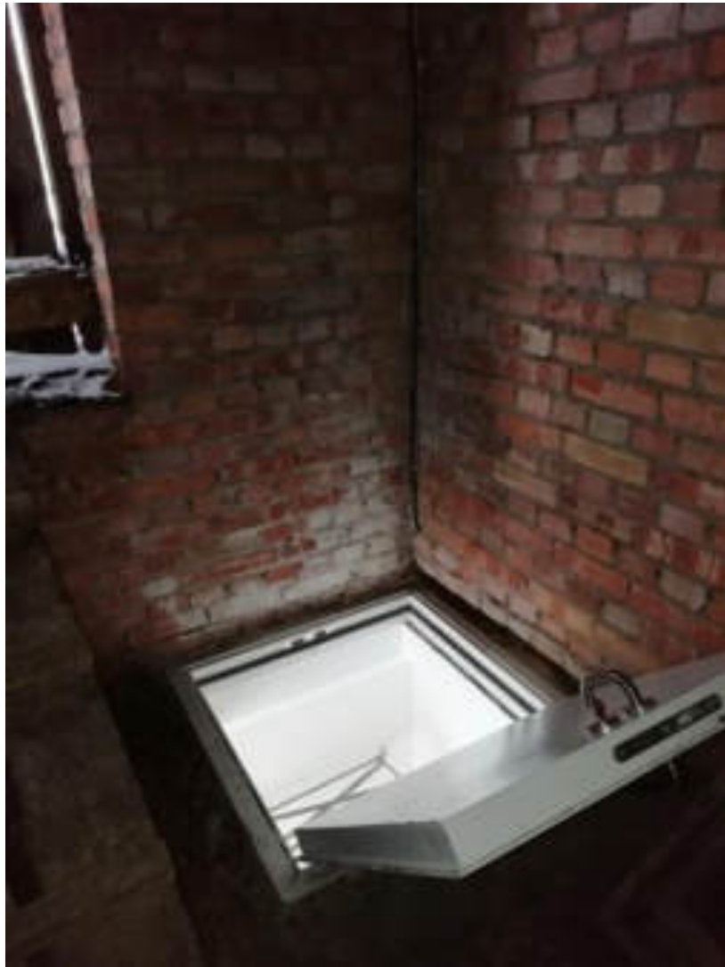
Фото 32. Люк выхода в чердачное помещение с лестницы 3 корпуса 2
