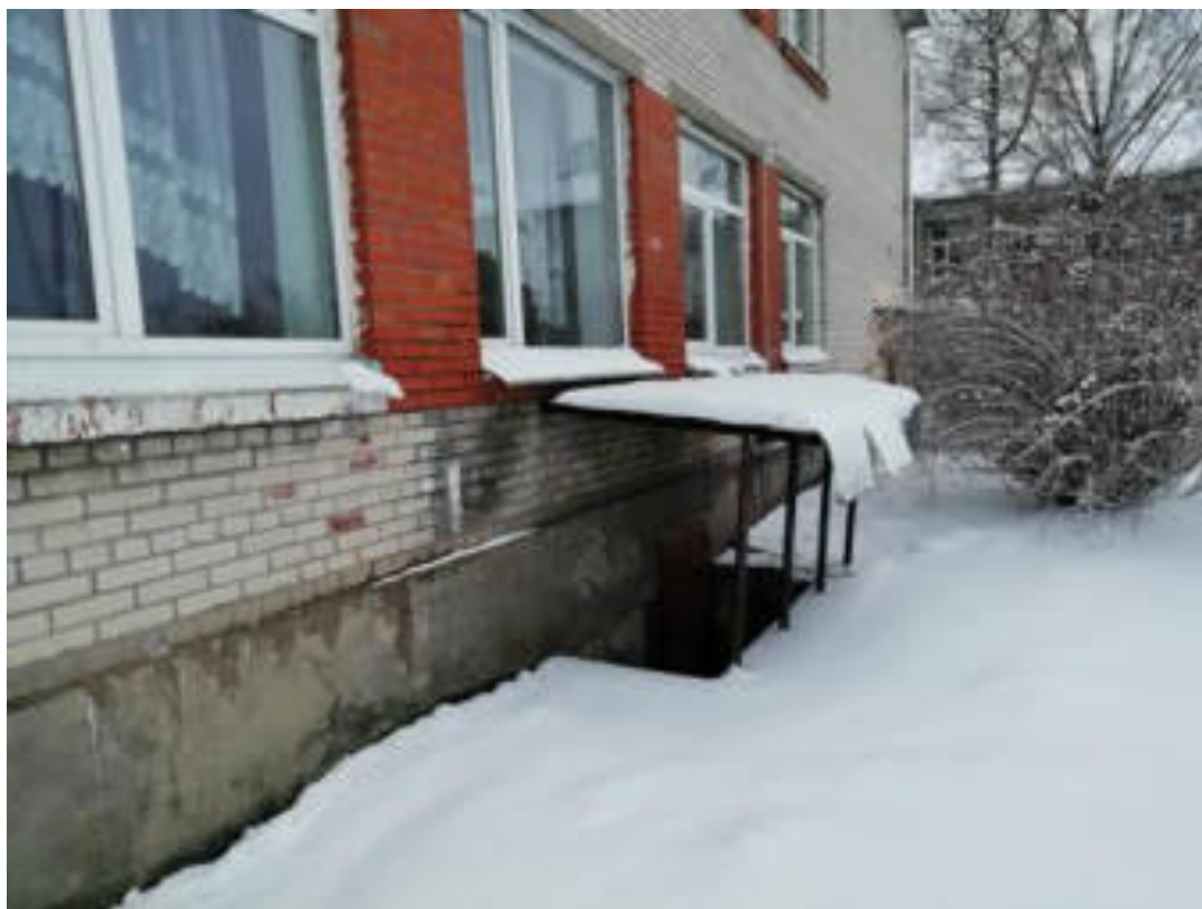
Фото 22. Вход в подвал корпуса 2. Козырёк над входом в подвал
