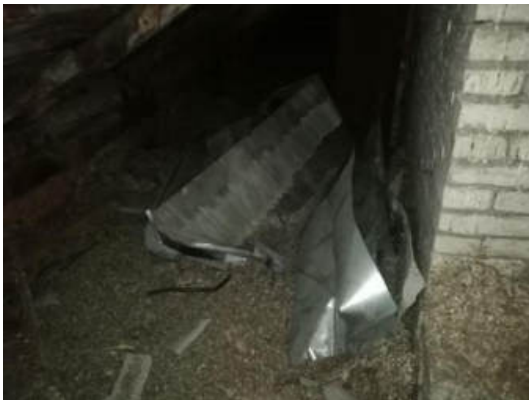
Фото 62. Чердачное помещение, корпус 1. Строительный мусор
