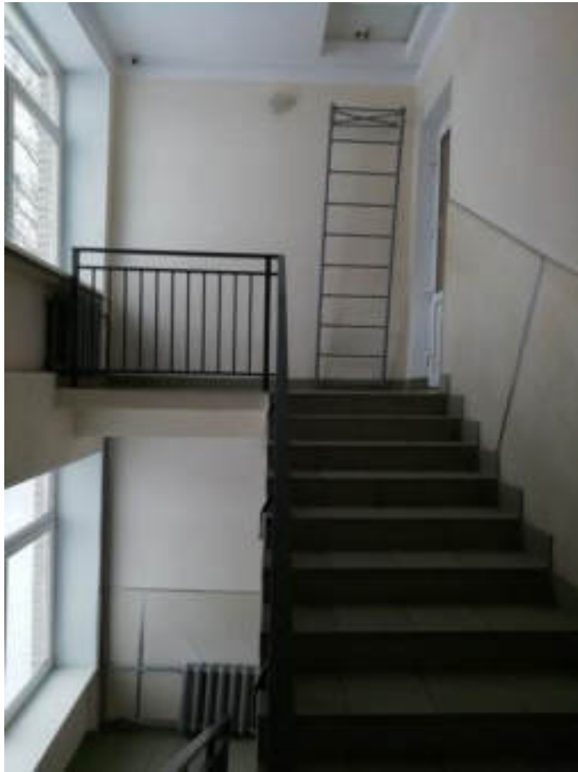
Фото 94. Лестница 2 корпус 2. Лестница выхода на плоскую кровлю
