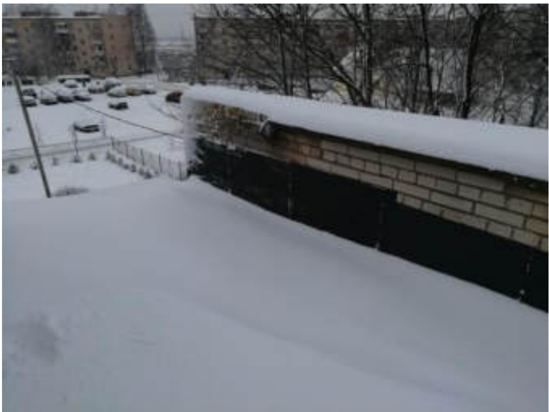
Фото 35. Отсутствие фрагмента покрытия парапета участка стены северной стороны. Следы намокания кирпичной кладки
