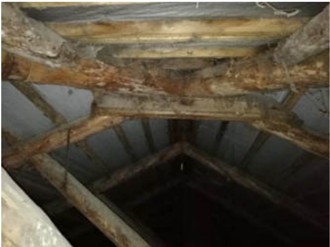
Фото 47. Чердачное помещение, корпус 1. Стропильная система, обрешётка. Просвет в коньке кровли. Старые следы намокания деревянных конструкций
