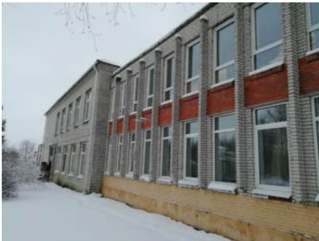
Фото 12. Здание школы, переход от корпуса 2 к корпусу 1, восточная сторона. Намокание и трещины по штукатурке цоколя
