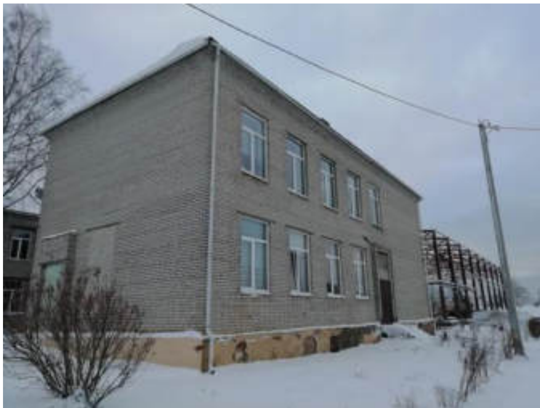
Фото 28. Здание школы, корпус 1, западная сторона. Намокание, трещины и отслоение штукатурки цоколя
