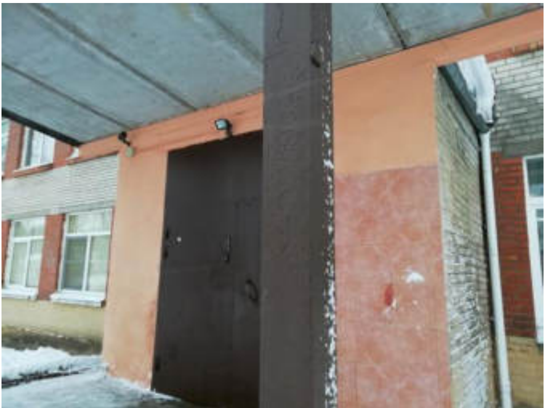
Фото 2. Плиты покрытия и металлоконструкции козырька главного входа. Выветренные швы, следы намокания плит покрытия. Следы коррозии и старой краски м/к стойки
