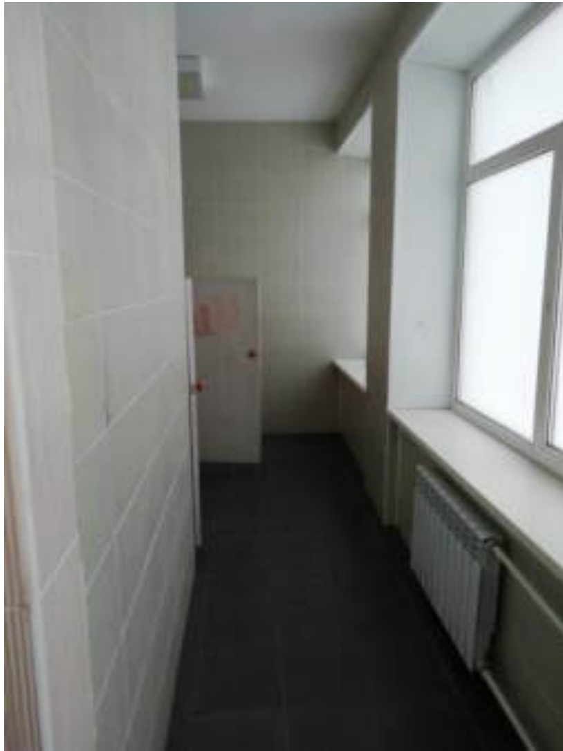
Фото 89. Санузел. 2-ой этаж школы
