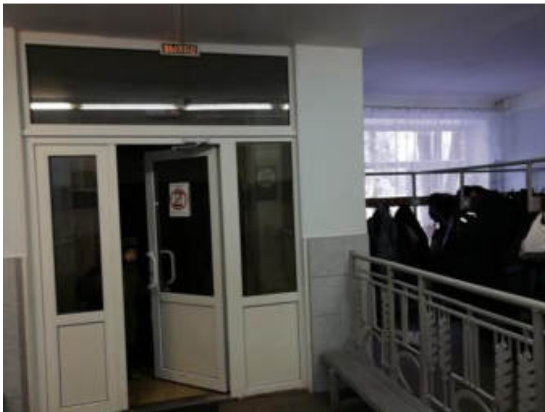
Фото 97. Входная зона главного входа. Выход в тамбур. Дверной блок из ПВХ профиля
