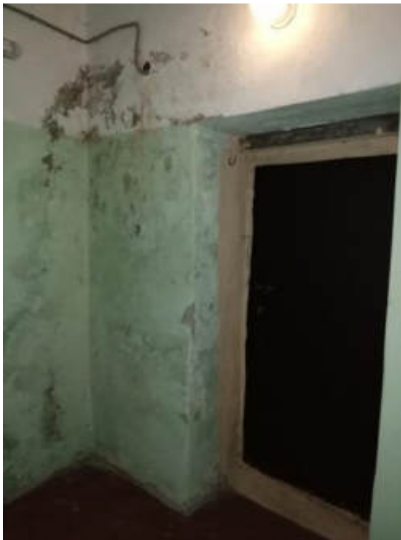
Фото 91. Эвакуационный выход. Лестница 2 корпус 2
