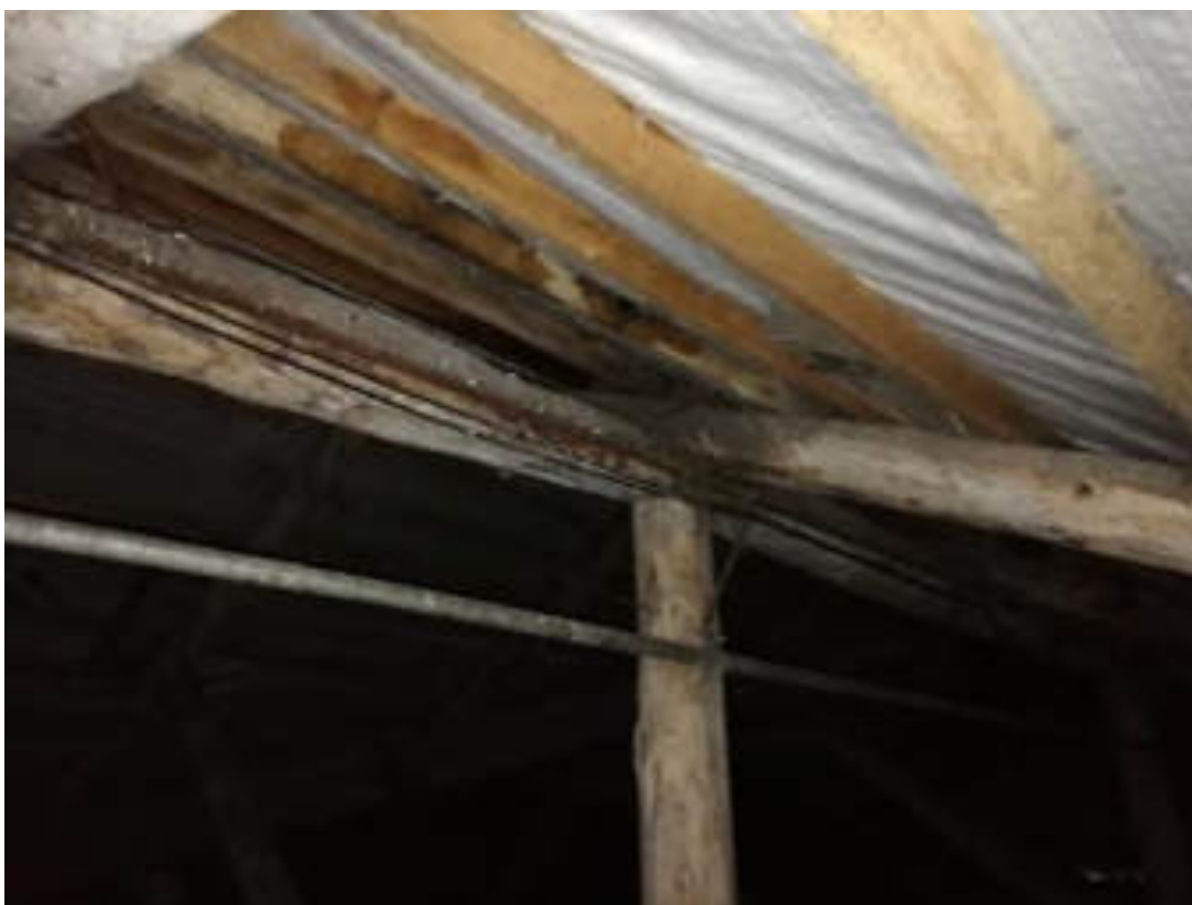
Фото 52. Чердачное помещение, корпус 1. Стропильная система, обрешётка. Старые и свежие следы намокания деревянных конструкций
