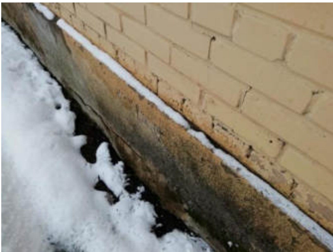
Фото 10. Цоколь здания школы восточной стороны. Намокание и трещины по штукатурке цоколя
