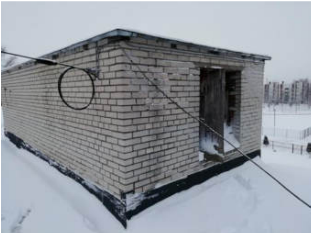
Фото 34. Помещение выхода на плоскую кровлю корпуса 2
