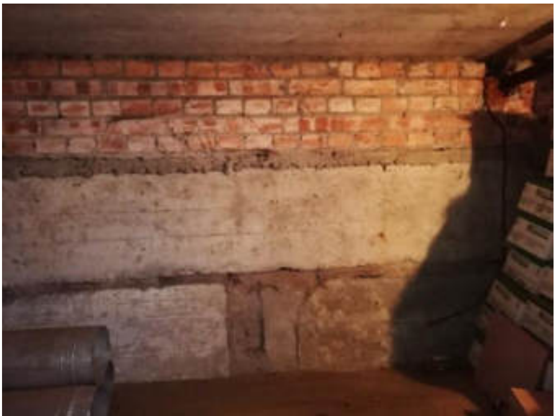
Фото 68. Подвал корпуса 2. Фундамент здания. Плиты перекрытия над подвалом
