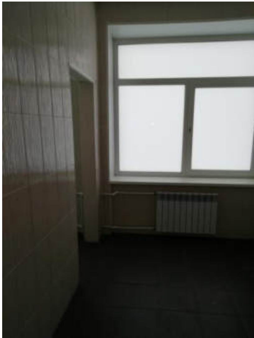
Фото 88. Санузел. 2-ой этаж школы
