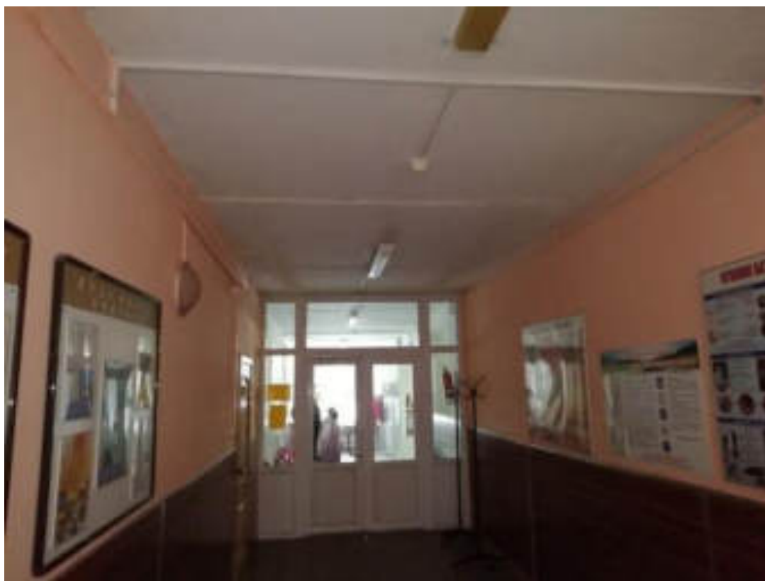
Фото 100. Выход в входную зону главного входа. Дверной блок из ПВХ профиля
