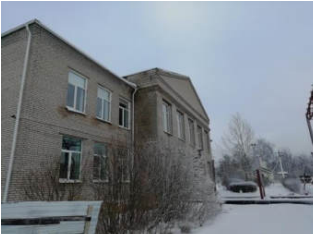
Фото 30. Здание школы, корпус 1, южная сторона. Снег на кирпичной кладке карниза. Минимальный карнизный свес кровли
