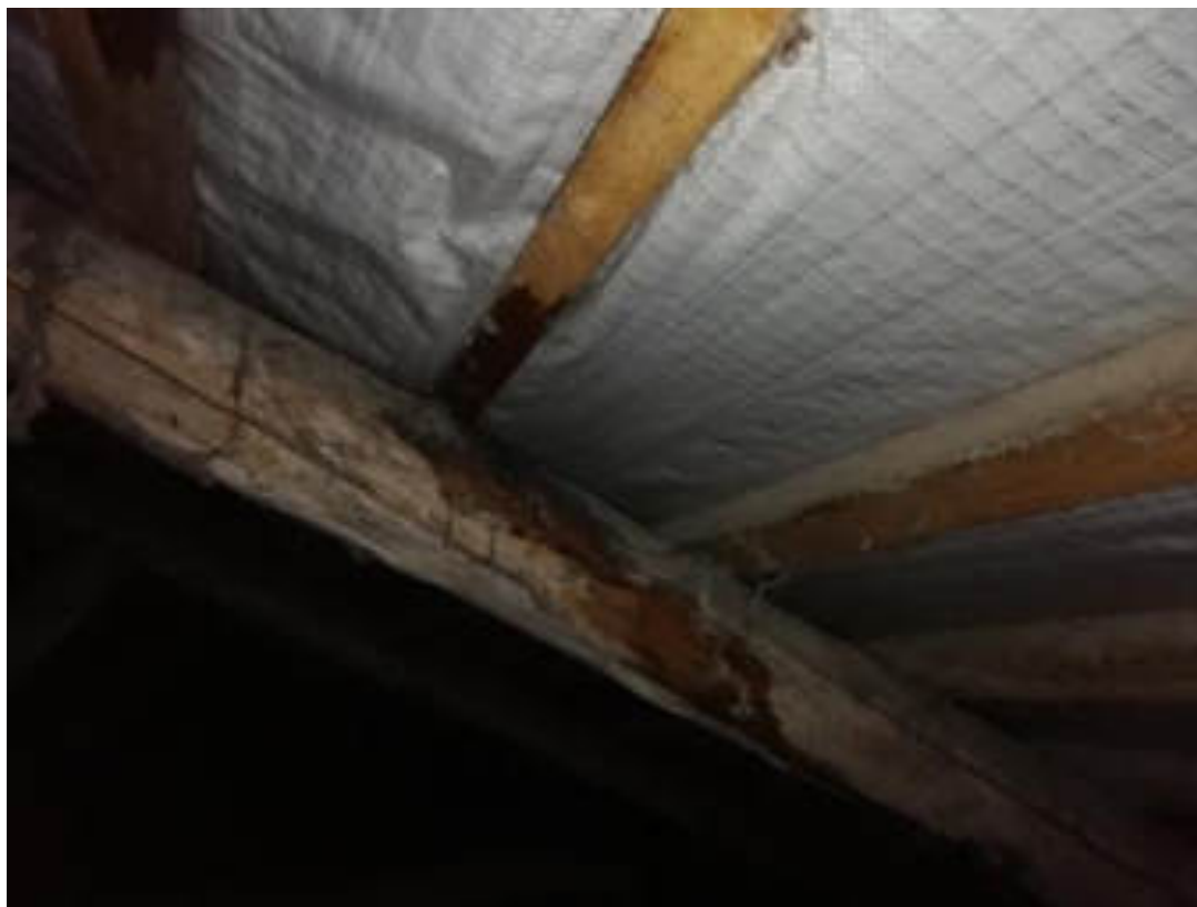
Фото 55. Чердачное помещение, корпус 1. Стропильная система, обрешётка. Свежие следы намокания деревянных конструкций
