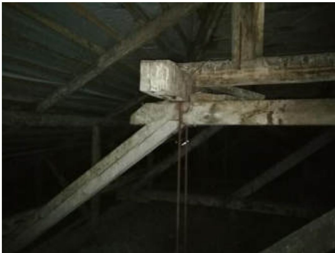
Фото 65. Чердачное помещение, корпус 1. Стропильная система. Старые следы намокания деревянных конструкций
