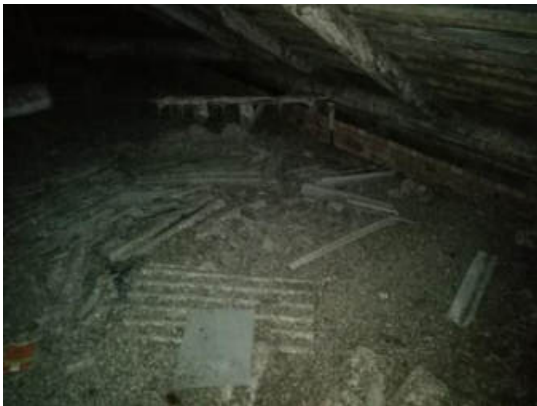
Фото 66. Чердачное помещение, корпус 1. Строительный мусор
