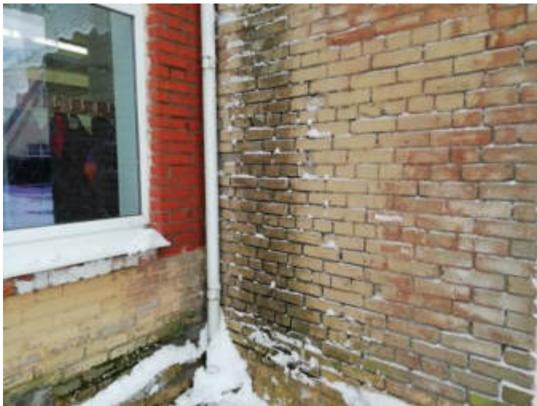
Фото 7. Кирпичная кладка левой стены тамбура главного входа. Выветренные швы, следы намокания кирпичной кладки
