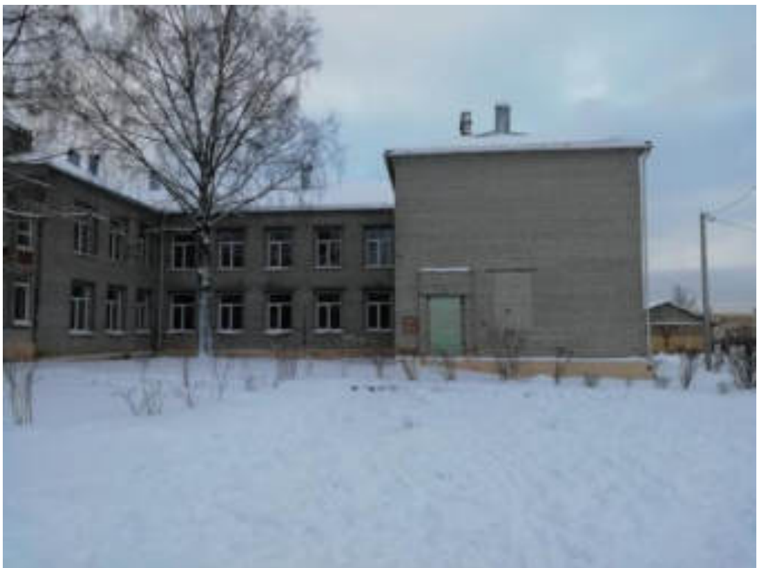
Фото 27. Здание школы корпус 1, северная сторона
