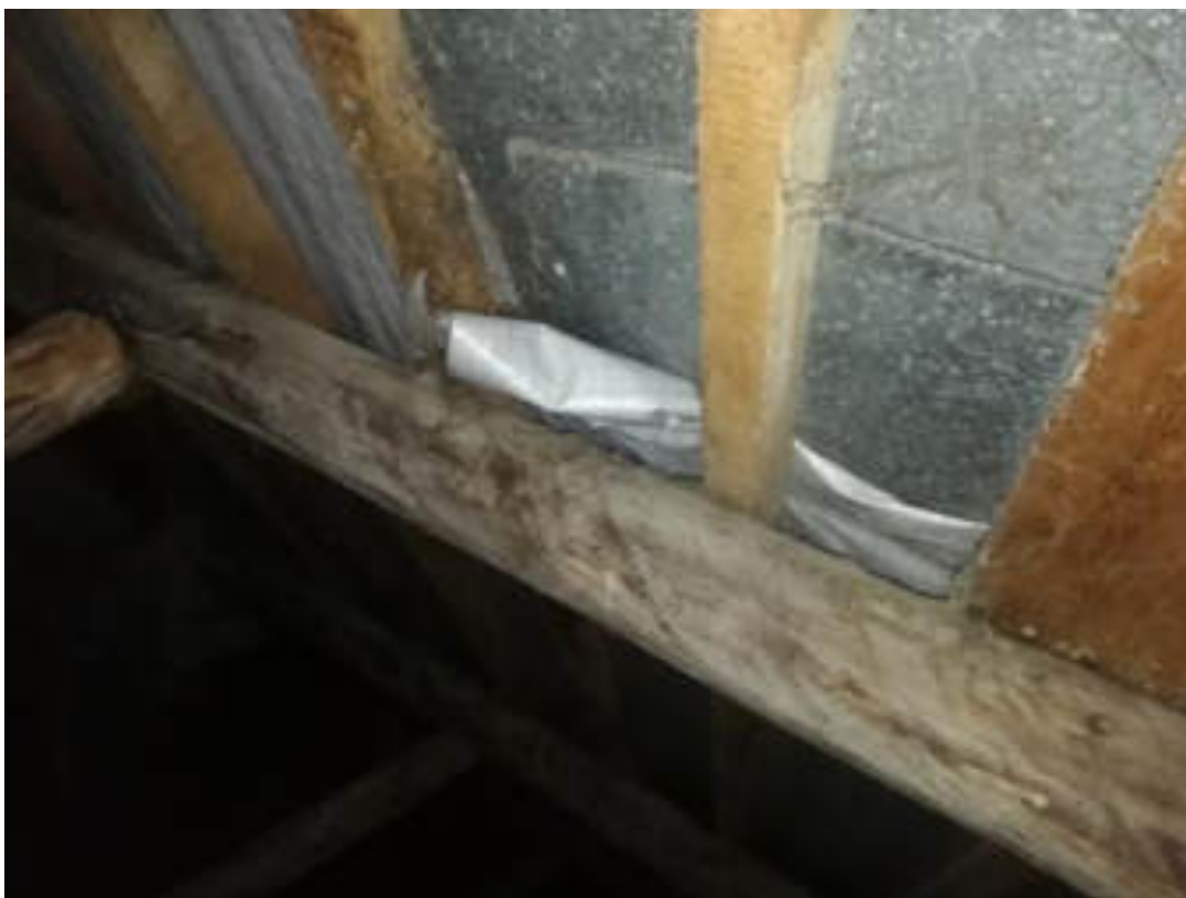
Фото 43. Чердачное помещение, корпус 1. Стропильная система, обрешётка. Некачественно уложенная ветрозащита
