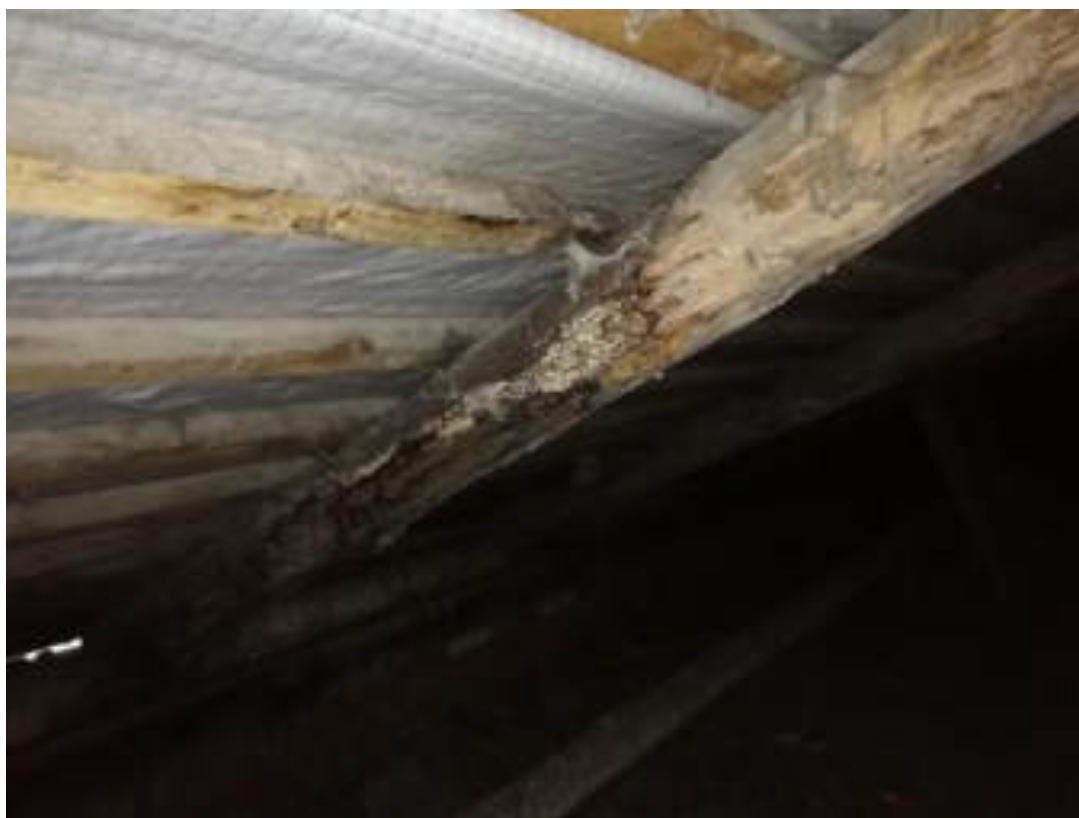
Фото 56. Чердачное помещение, корпус 1. Стропильная система, обрешётка. Старые следы намокания деревянных конструкций. Гниение участка стропильной ноги
