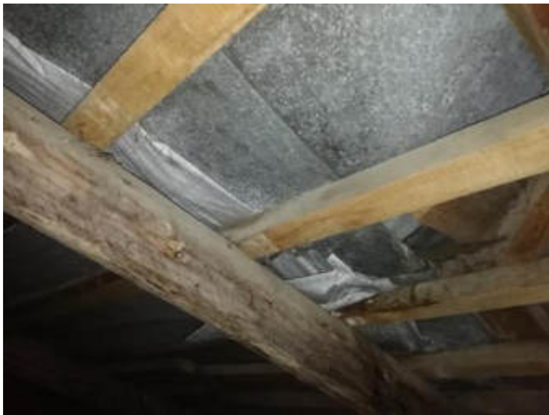
Фото 44. Чердачное помещение, корпус 1. Стропильная система, обрешётка. Следы намокания обрешётки. Некачественно уложенная ветрозащита
