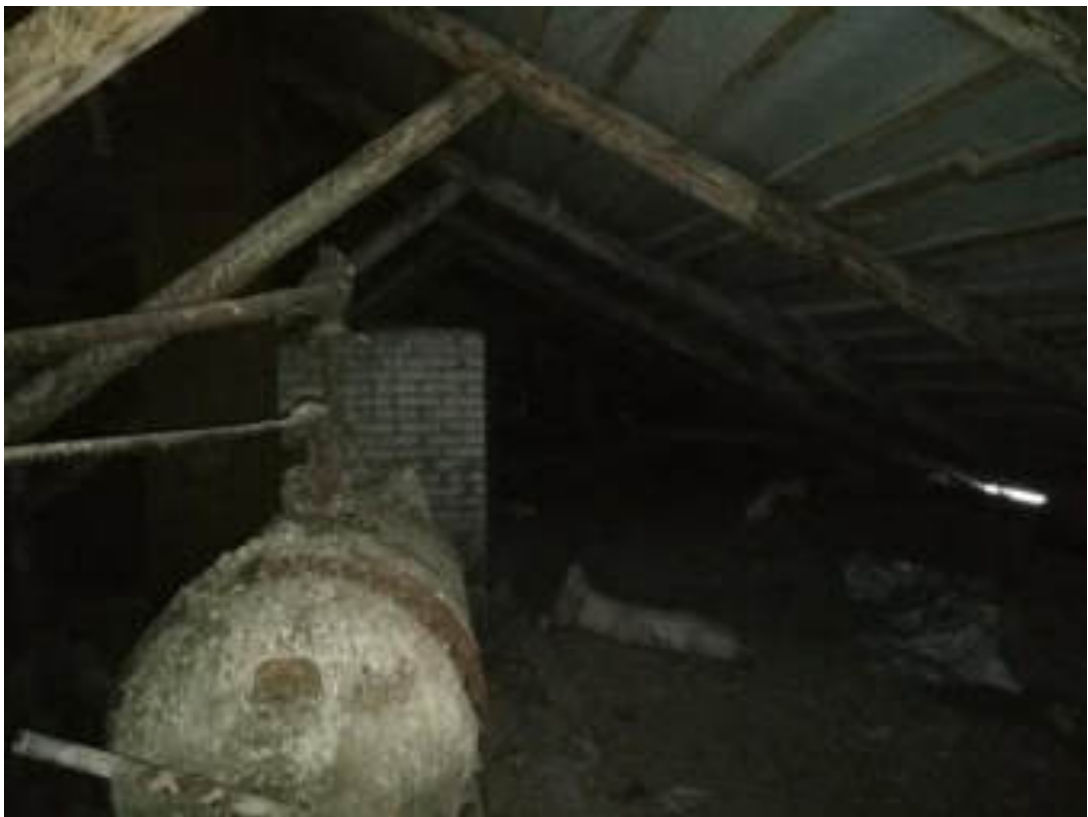
Фото 39. Чердачное помещение, корпус 1. Стропильная система
