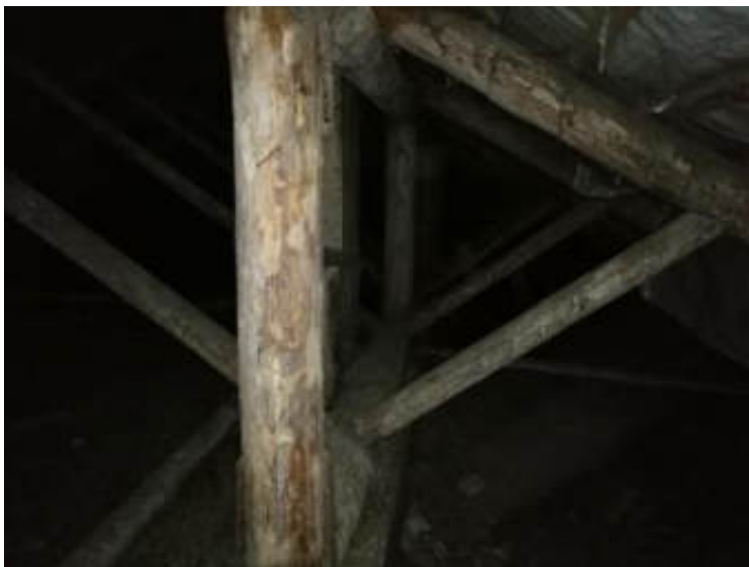
Фото 58. Чердачное помещение, корпус 1. Стропильная система, стойки, укосы
