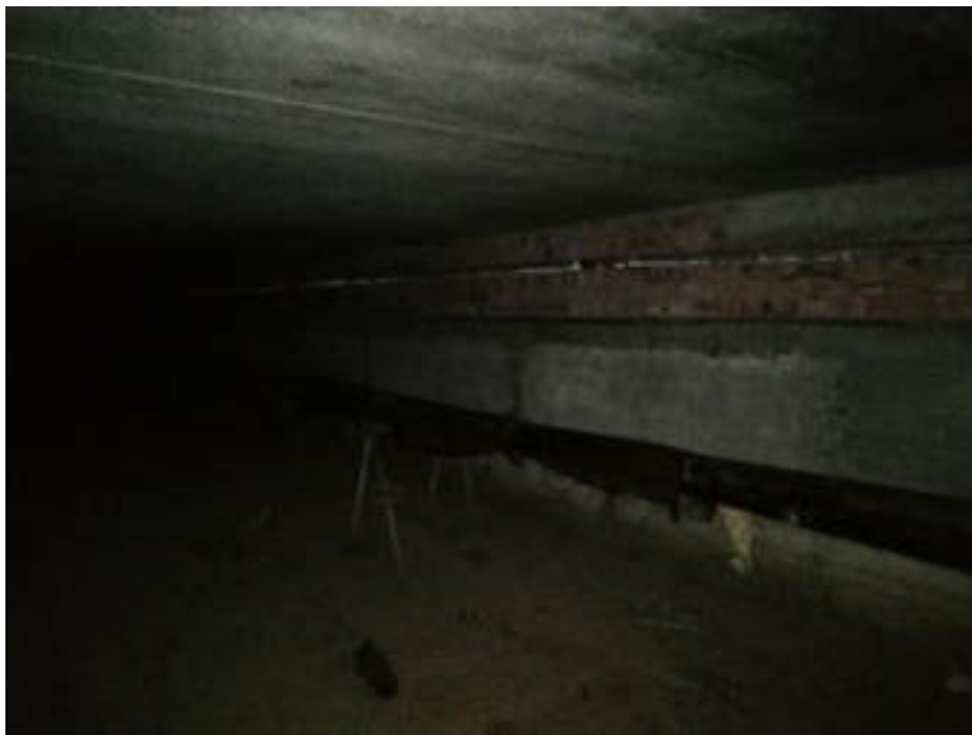
Фото 73. Подвал корпуса 2. Фундамент здания. Плиты перекрытия над подвалом. Полы
