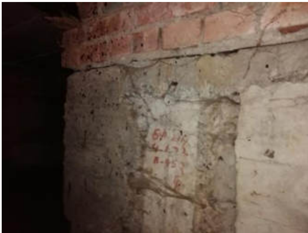
Фото 69. Подвал корпуса 2. Фундамент здания
