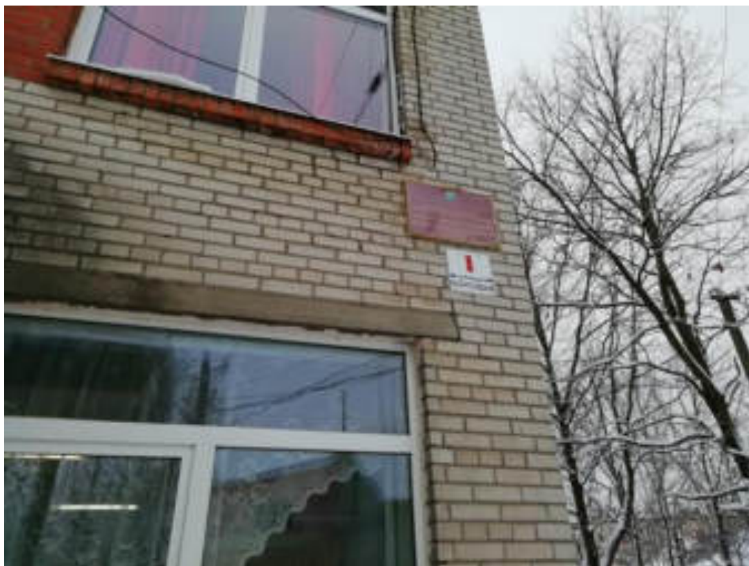
Фото 6. Участок стены справа от крыльца главного входа. Следы от намокания кирпичной кладки
