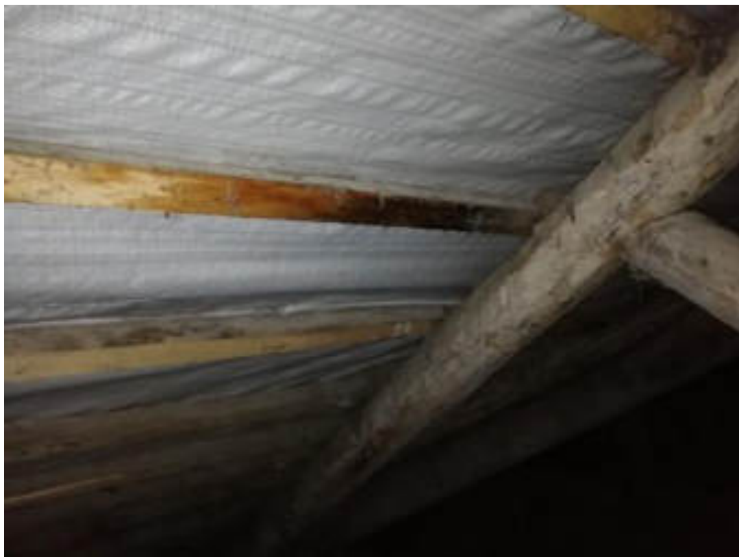
Фото 53. Чердачное помещение, корпус 1. Стропильная система, обрешётка. Свежие следы намокания деревянных конструкций
