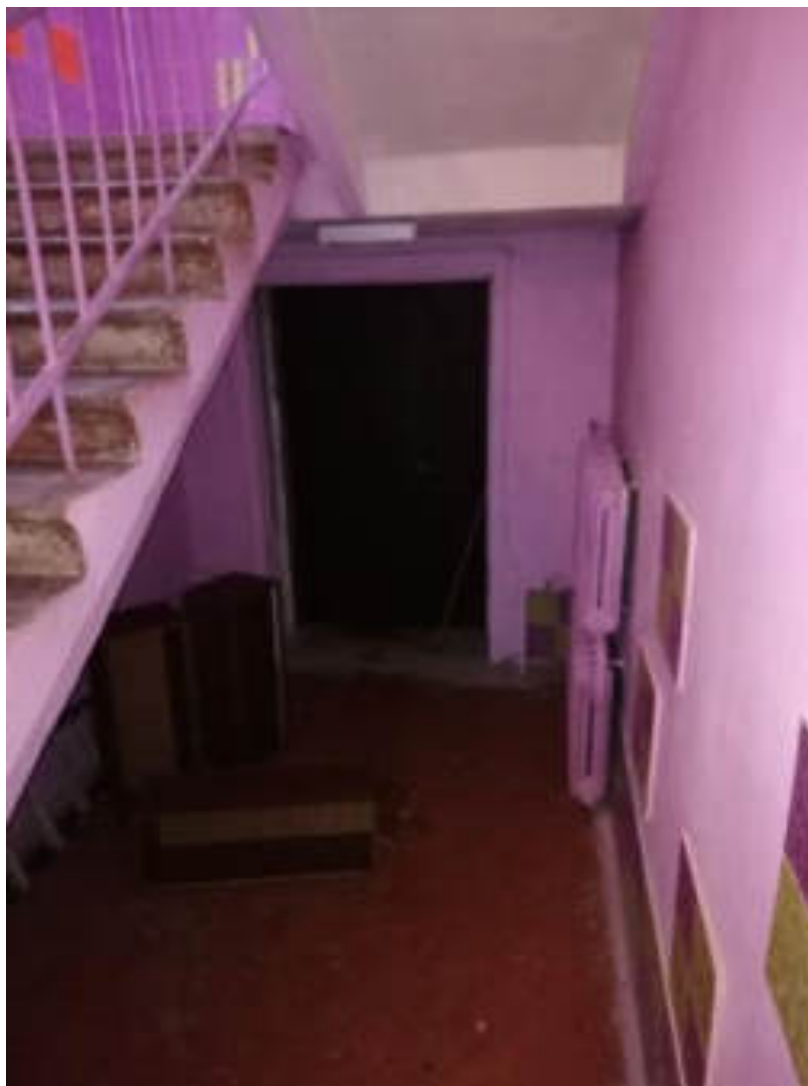
Фото 82. Лестница 1 корпус 1. Наборные ступени по металлическим косоурам. Эвакуационный выход
