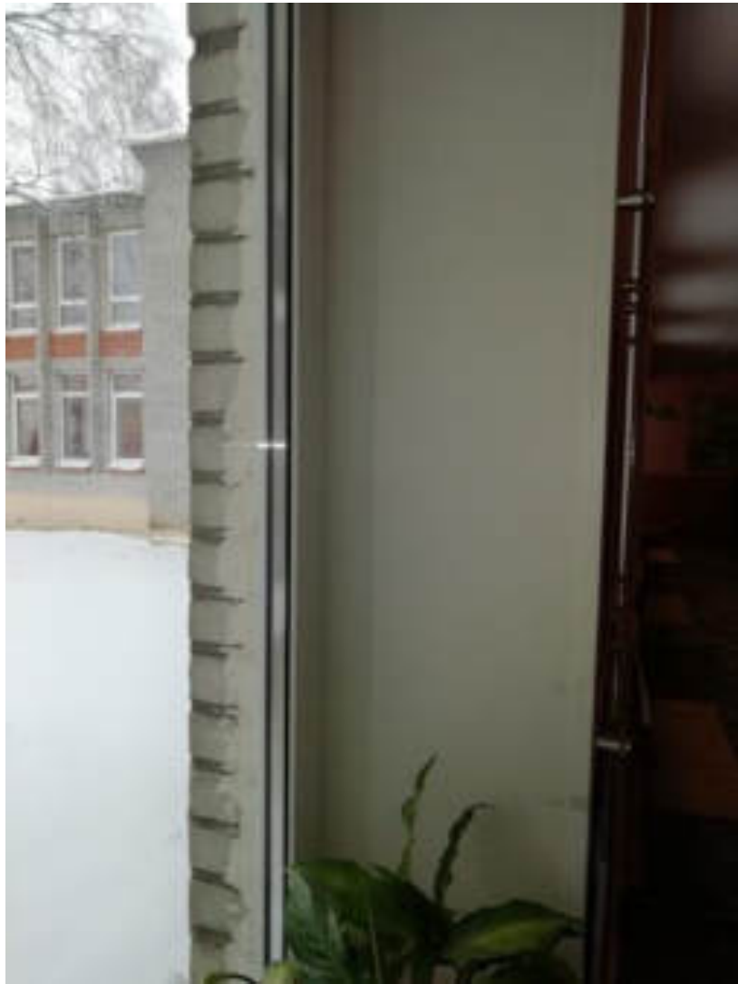
Фото 107. Оконный откос, первый этаж школы, корпус 1
