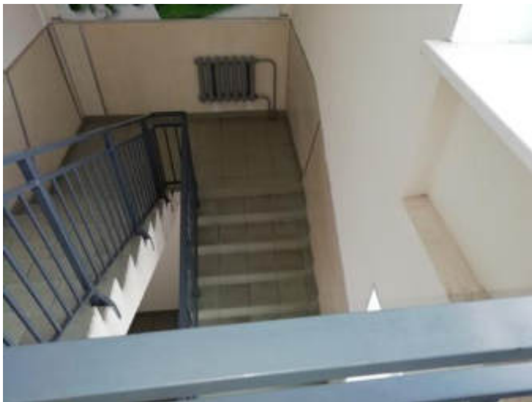
Фото 93. Лестница 3 корпус 2. Железобетонные лестничные марши и площадки, облицованные керамогранитом
