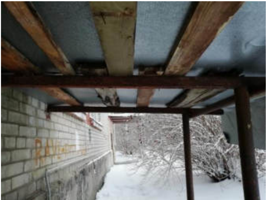
Фото 24. М/к, обрешётка и покрытие козырька над входом в подвал корпуса 2
