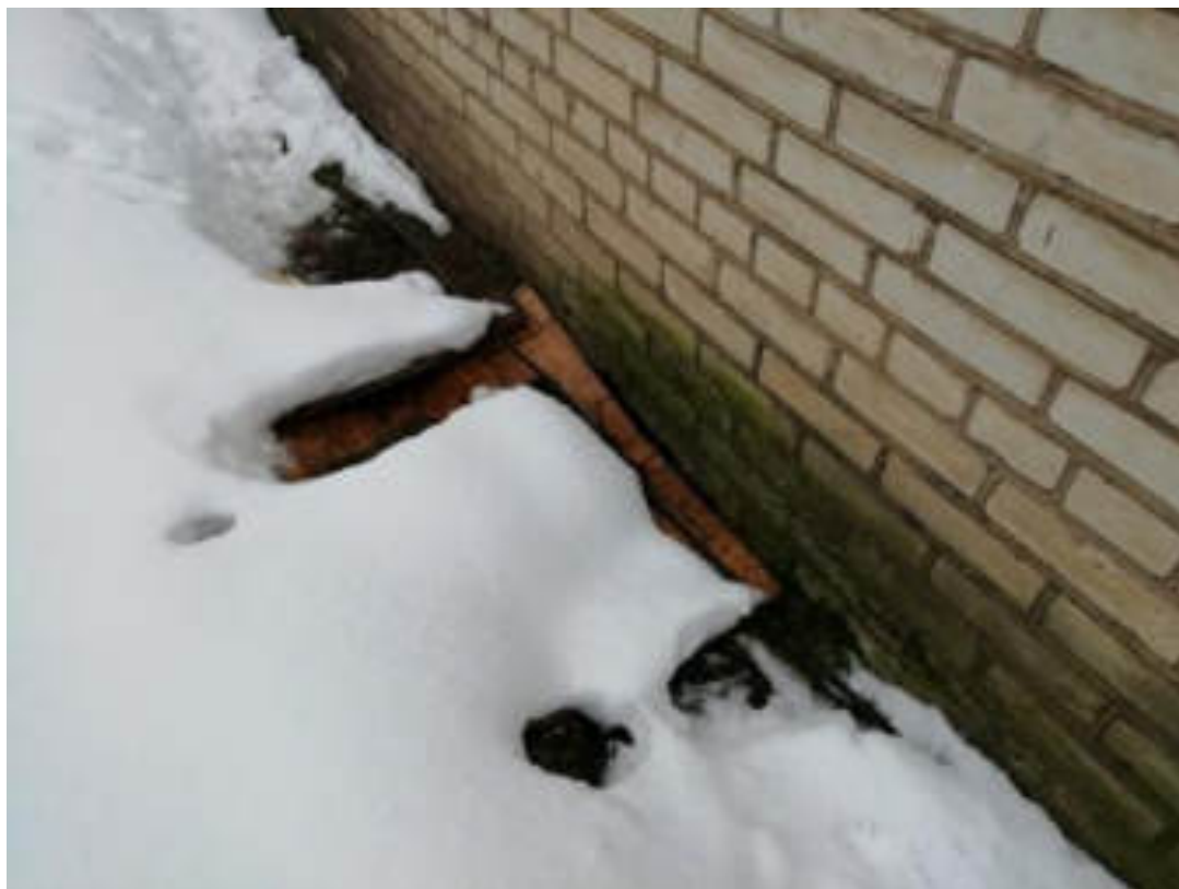
Фото 13. Продух подвала корпуса 1, восточная сторона здания. Следы намокания кирпичной кладки
