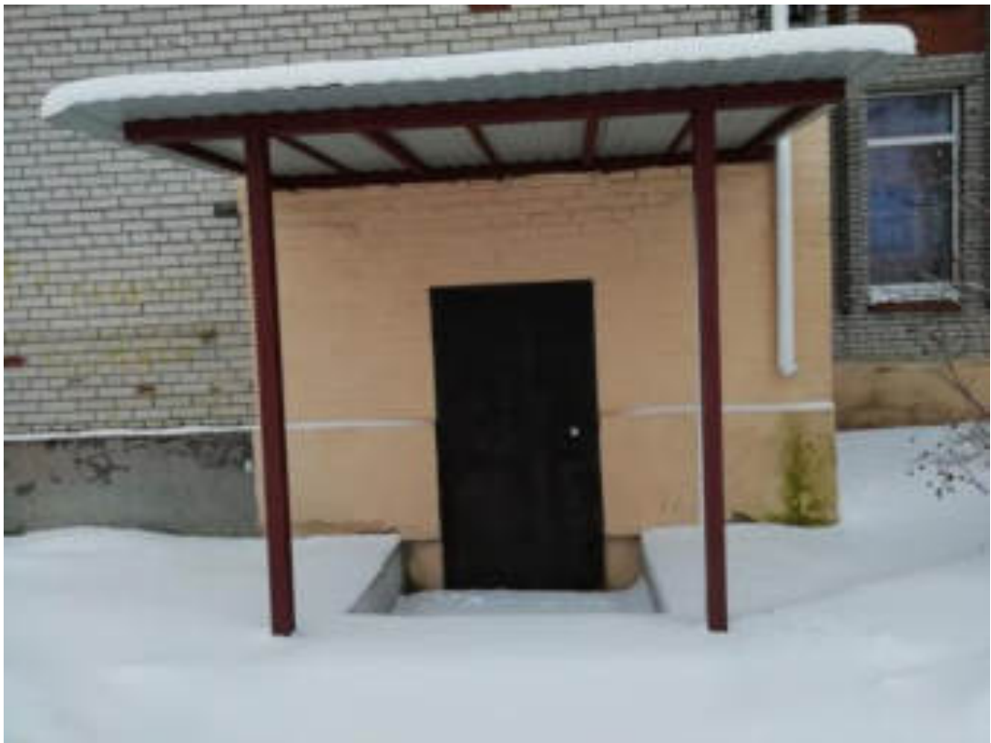
Фото 26. Эвакуационный выход из корпуса 2 по лестнице 2. Козырёк над выходом
