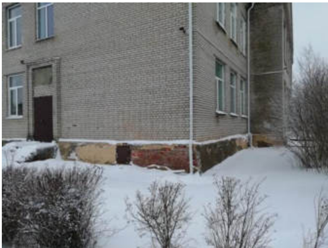
Фото 29. Здание школы, корпус 1, западная сторона с переходом на южную. Эвакуационный выход из корпуса 1 по лестнице 1.
