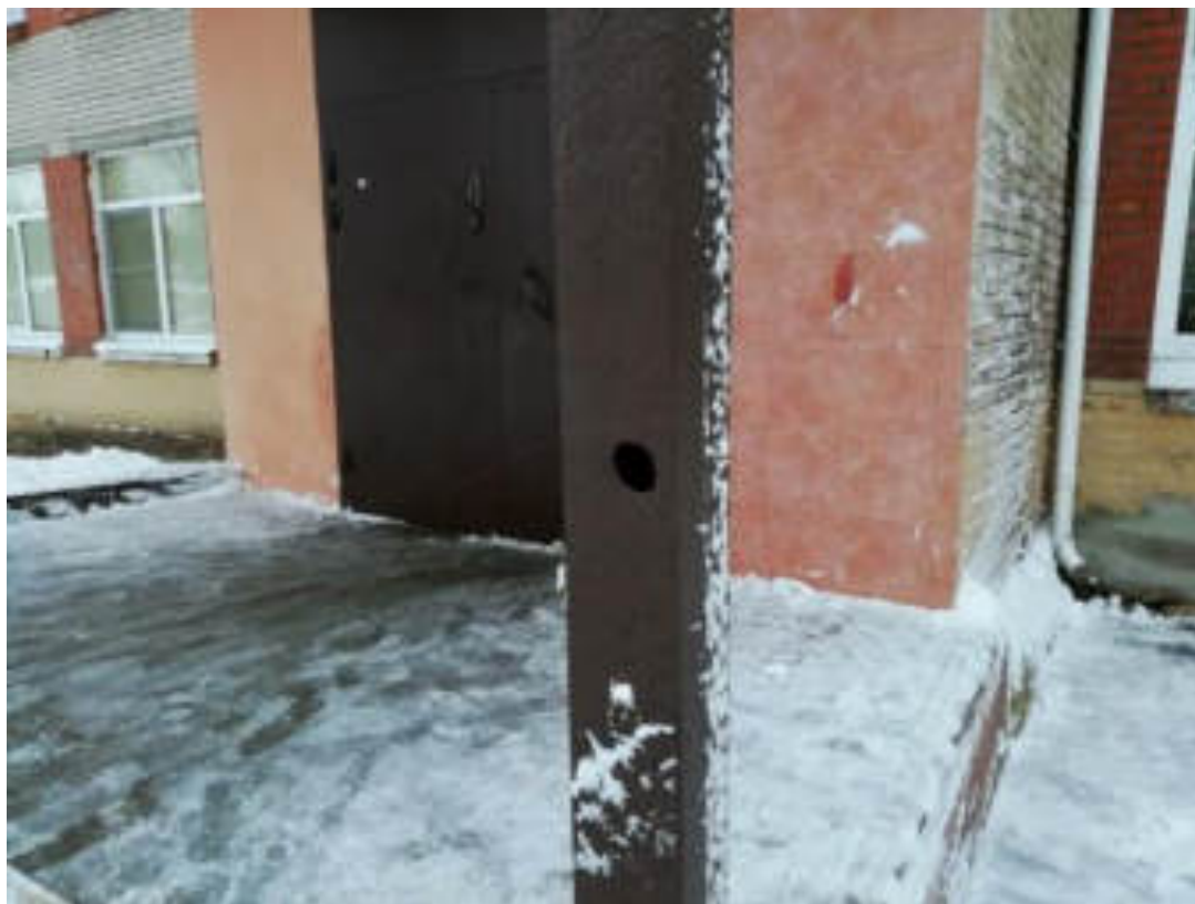
Фото 3. Металлоконструкции козырька главного входа. Следы коррозии и старой краски и отверстие м/к стойки
