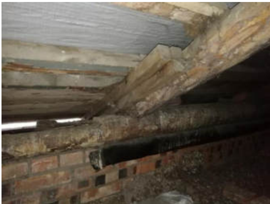
Фото 45. Чердачное помещение, корпус 1. Стропильная система, выпуска кобылок. Отсутствует участок гидроизоляции под мауэрлатом
