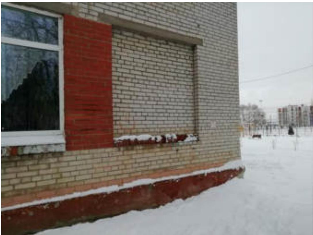
Фото 18. Цоколь здания школы северной стороны. Намокание и трещины по штукатурке цоколя
