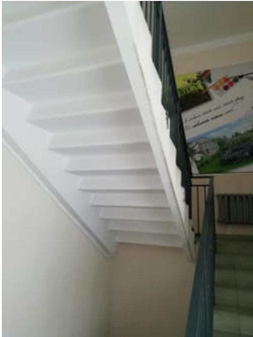
Фото 95. Лестница 3 корпус 2. Железобетонные лестничные марши
