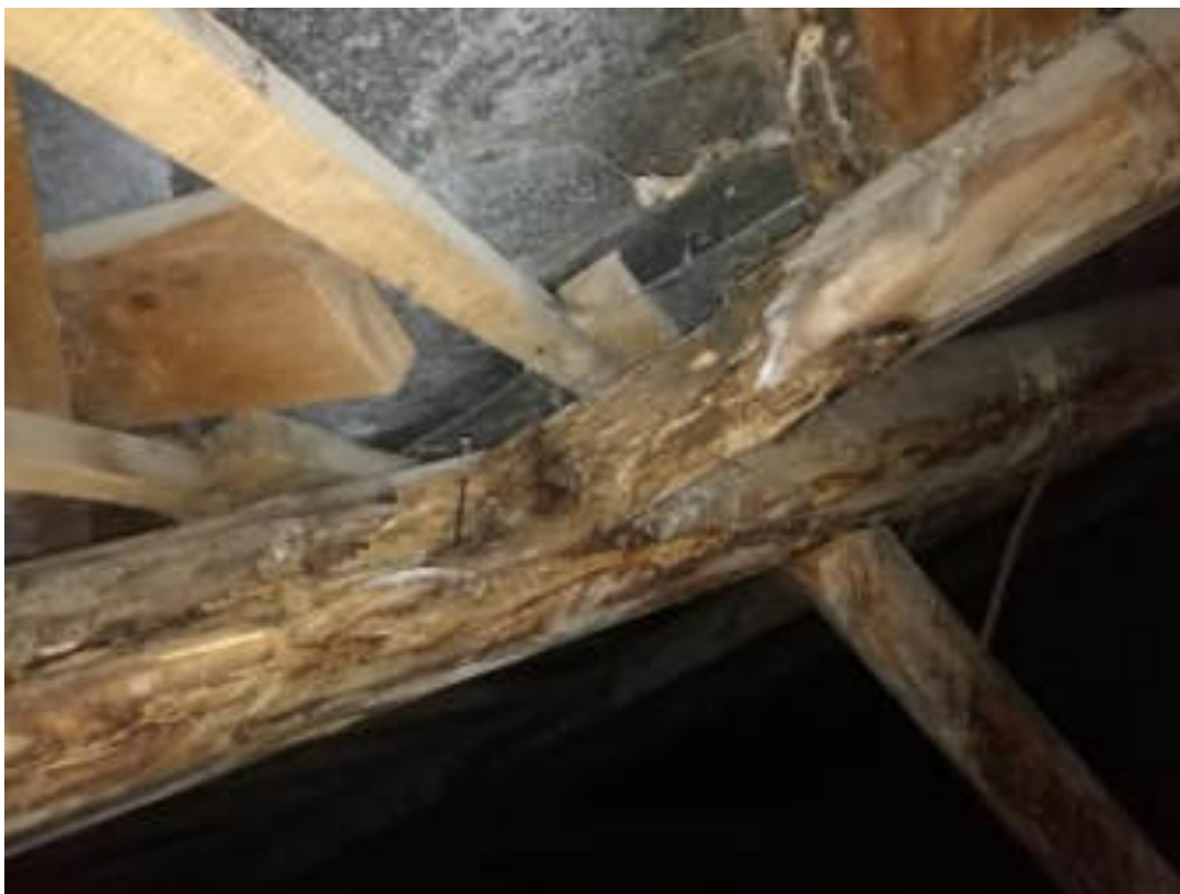
Фото 42. Чердачное помещение, корпус 1. Стропильная система. Гнилые концы и участки стропил
