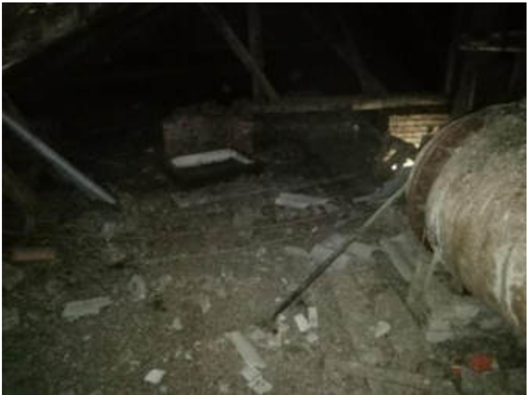
Фото 38. Чердачное помещение, корпус 1. Люк в чердачное помещение. Строительный мусор
