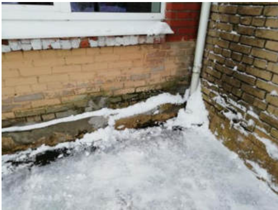
Фото 8. Участок стены слева от крыльца главного входа. Намокание и трещины по штукатурке цоколя
