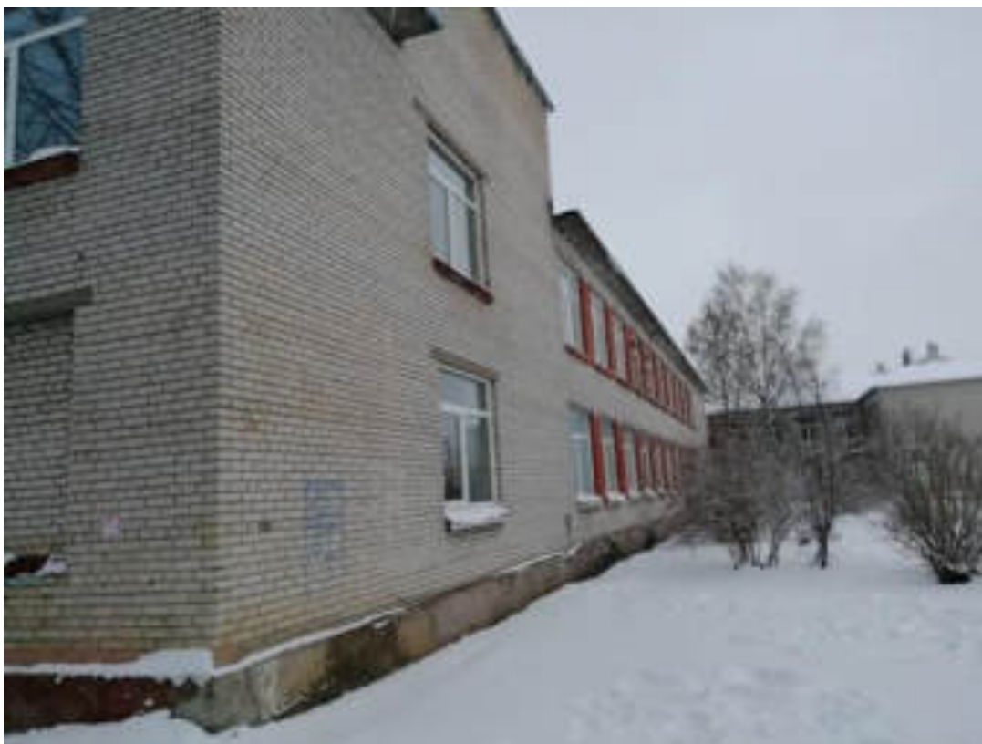
Фото 20. Здание школы, корпус 2, западная сторона. Намокание и трещины по штукатурке цоколя
